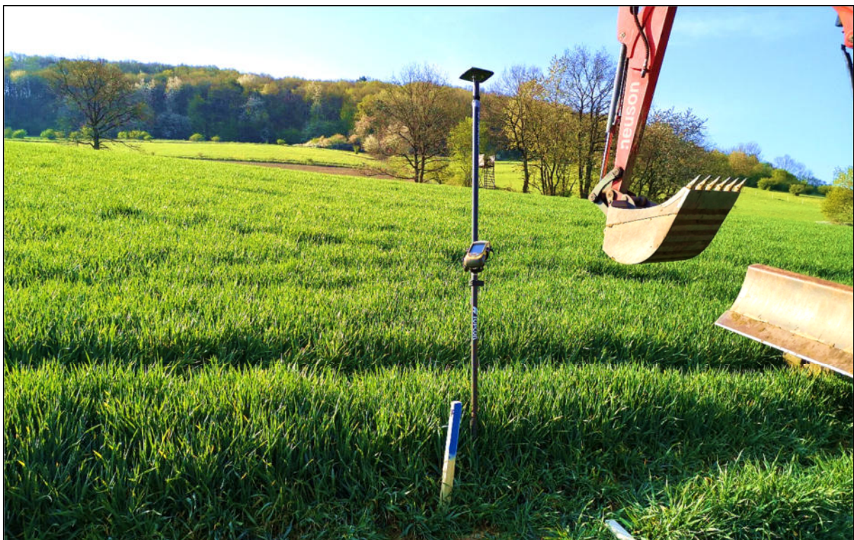
Abbildung 5.34: Baggerschurf SCH 7 , vor Ausführung des Schurfs
