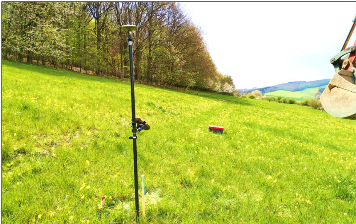
Abbildung 5.54: Baggerschurf SCH 12 , vor Ausführung des Schurfs
