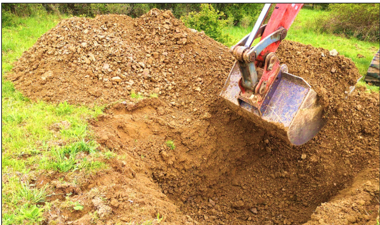
Abbildung 5.12: Baggerschurf SCH 1
