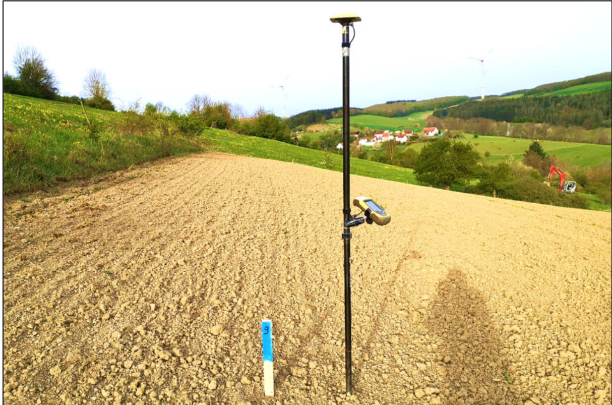
Abbildung 5.43: Baggerschurf SCH 9 , vor Ausführung des Schurfs
