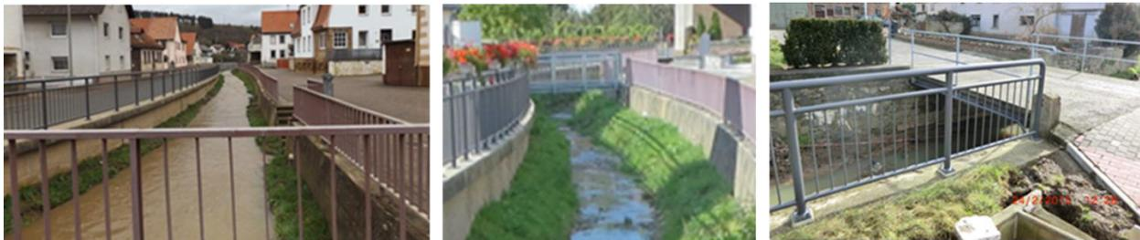
Insbesondere an den stark abflussbegrenzenden Brücken sollten Anlandungen konsequent entfernt werden. Dies ist auch auf die Ufer oberhalb und unterhalb der Brücken auszuweiten, wenn die Anlandungen dort strömungslenkend sind und zu einer zusätzlichen Einengung beitragen.
