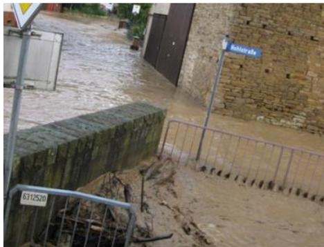
Im Ort ist auf der Moschelbrücke Hohlstraße eine gemauerte Brüstungsmauer vorhanden. Die Mauer hat keinen relevanten negativen Einfluss auf den Hochwasserabfluss, da Hochwasser rechts und links an der Brüstungsmauer vorbeiströmen kann. Deshalb muss die Mauer aus Hochwasserschutzgründen nicht beseitigt werden. In einer Bürgerversammlung wurde der Wunsch erhoben, die Mauer auch aus Gründen der Sichtverhältnisse zu entfernen.
