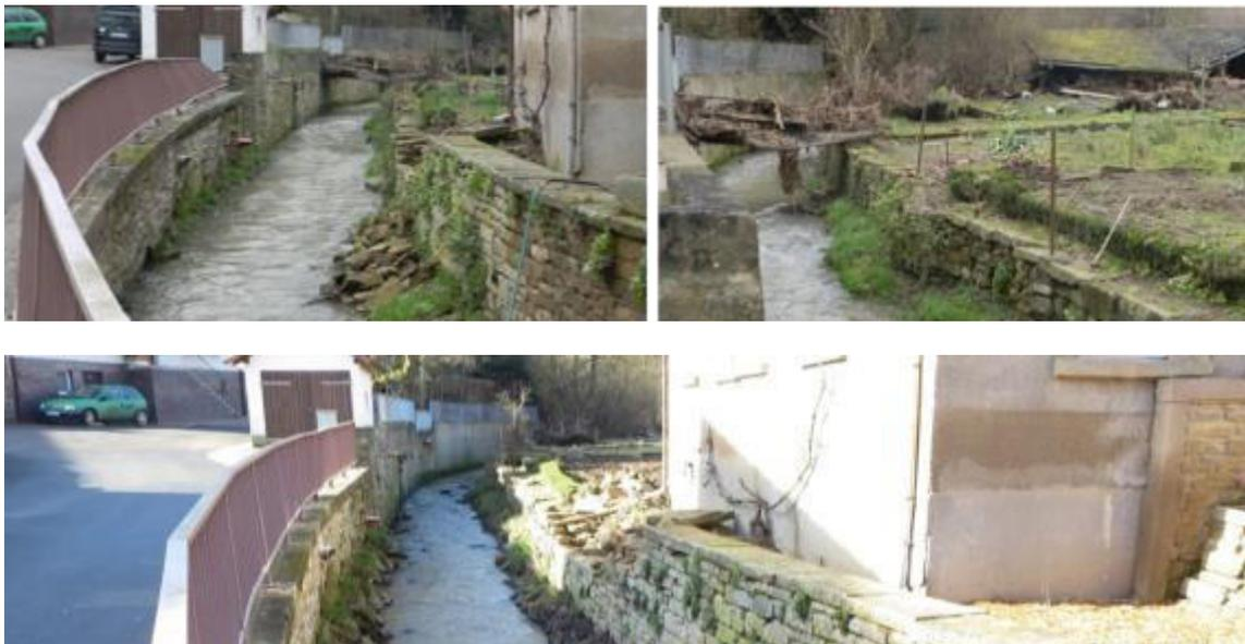
Entlang der weiteren Hohlstraße ist die Moschel in einem leistungsfähigen Rechteckprofil geführt und die Hohlstraße rechts und der Anliegerweg links können bei Hochwasser als Notabflusswege fungieren. Damit liegen gute Voraussetzungen für einen geordneten und schadlosen Abfluss von Hochwasser bis deutlich über  $HQ_{100}$  vor.
