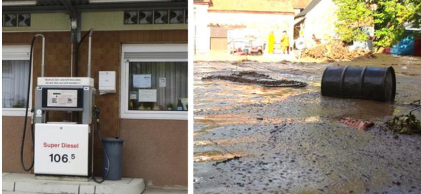
Für die Lagerung von Frisch- und Altöl sowie Dieselkraftstoff gelten analoge Anforderungen wie für die Heizöllagerung. Auch für diese Behälter und Anlagen gilt, dass sie so gesichert sein müssen, dass sie bei Hochwasser nicht aufschwimmen oder umkippen können oder Leckagen entstehen.
