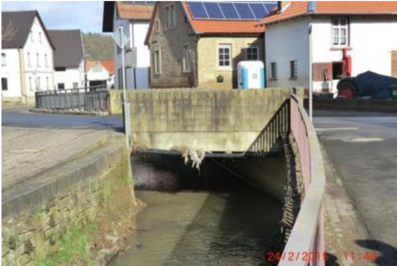
Daran ändert auch die Brücke Hohlstraße nichts, denn auch unter der Brücke kann ein Hochwasser was seltener vorkommt als HQ<sub>100</sub> ohne Aufstau abgeführt werden. Voraussetzung ist natürlich, dass der Brückenquerschnitt frei ist.
