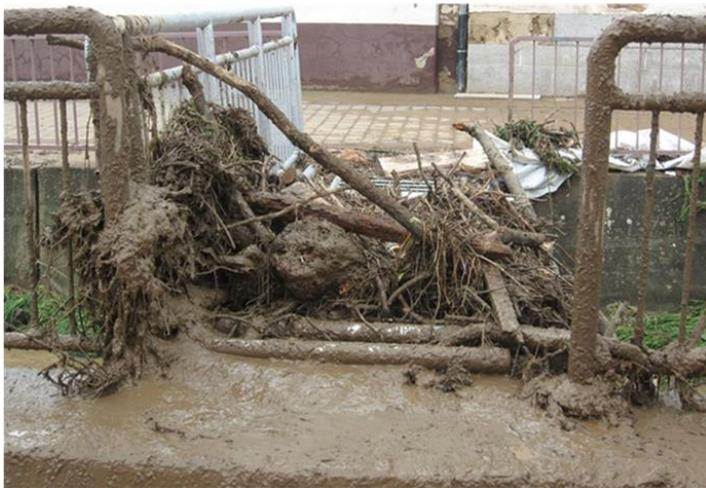
Eine hydraulische Überprüfung ergab, dass unter dem Steg ein Hochwasser abgeführt werden kann, wie es statistisch gesehen alle 25 Jahre eintritt.
