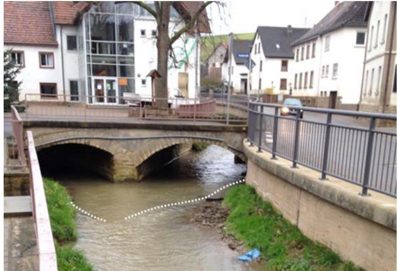
durch Einbringen von Natursteinen als Strömunglenker, die Fließgeschwindigkeit im Niedrigwasserbereich zu erhöhen und abflussbehindernde Ablagerungen unter der Brücke zu vermeiden.
