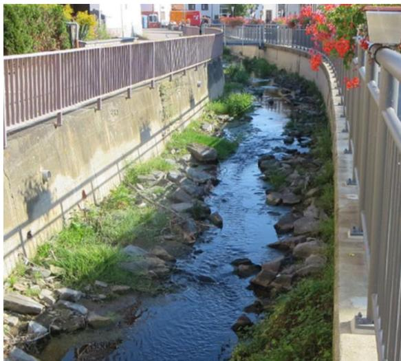
Hierfür konnten die noch bestehenden hohen Wülste im Uferbereich bis auf ein Niveau von etwa 15 bis 20 cm über der Sohle abgetragen werden. Die dabei gewonnenen Steine wurden so über die Sohle verteilt werden, dass Bereiche mit kleinräumig unterschiedlichem Abflussverhalten und Strömungsmustern, die Schutz- und Lebensraum für Fische und Kleinlebewesen bieten entstanden sind.
