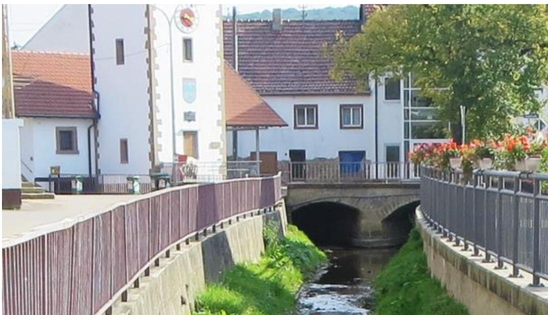
Unterhalb der Mündung des Ransenbaches fließt die Moschel bis ins Unterdorf in einem großzügigen, Rechteckprofil mit betonierten Ufermauern und zum Teil ausgeprägten Auflandungen im Uferbereich.
