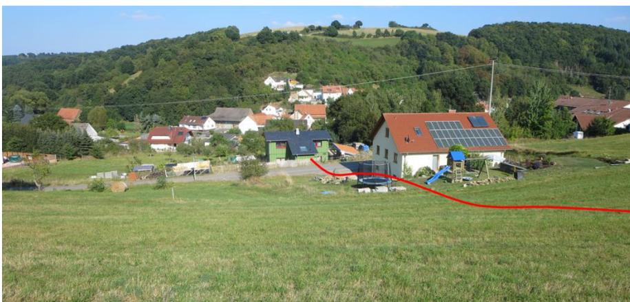
Hier besteht die Gefahr, dass Wasser dem talseitigen Grundstück, das sehr tief unter dem Straßenniveau angeordnet ist, zufließt. Die Situation kann sich mit weiterer Bebauung des Hanges verschärfen.
