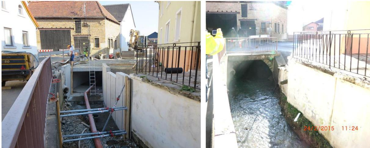
Die zerstörte Brücke über die Moschel im Bereich Dreispitz wurde zwischenzeitlich abgerissen und durch eine Furt ersetzt (s. auch Abschnitte 9.6.1).
