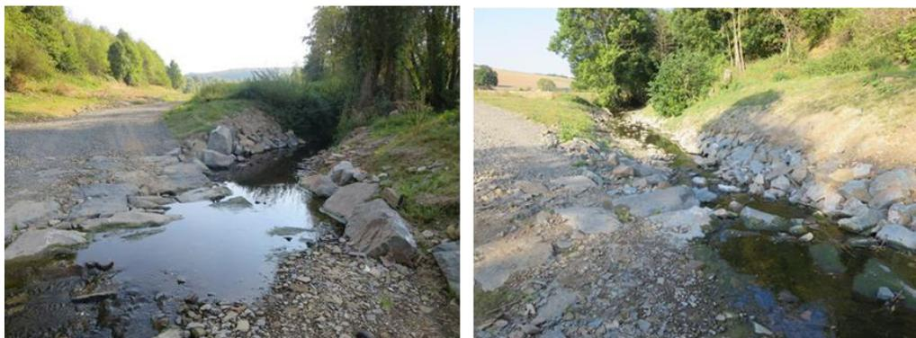
Die Brücke über die Moschel im Bereich Bornwiese ist nicht mehr befahrbar. Hier sollte geprüft werden, ob diese auch durch eine Furt ggf. in Kombination mit einem darunterliegenden Rohr ersetzt werden kann (s. auch Abschnitt 9.6.1).
