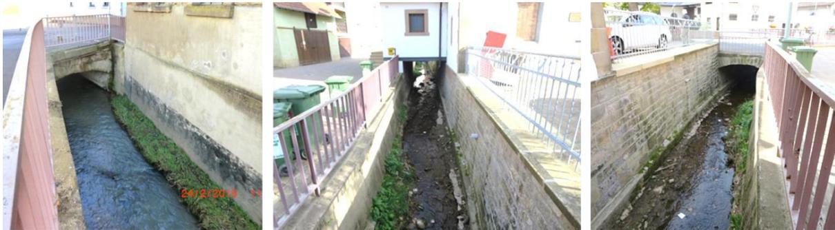
Die zwischen den Brücken liegenden Profile im Ransenbach können Wassermengen, die zum Teil deutlich über HQ100 liegen, abführen ohne auszufernen. Dies gilt auch für die Moschel auf der gesamten Länge. Hier stellen häufig auch die Brücken bis HQ100 keine relevanten Abflusshindernisse dar. Voraussetzung ist natürlich, dass der jeweilige Fließquerschnitt unter der Brücke frei ist.
