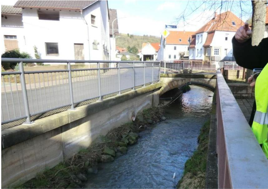
Im weiteren Verlauf ist die Moschel in einem Rechteckprofil mit beidseitigen massiven Ufermauern geführt. Rechts und links verlaufen Straßen, von denen sie durch Geländer getrennt ist. Die Straßen bilden bei Hochwasser Notabflusswege. Die Moschel quert einen Fußgängersteg zwischen Hauptstraße und Unterdorfstraße sowie die Zufahrt zu einem Privatgrundstück nördlich der Unterdorfstraße.
