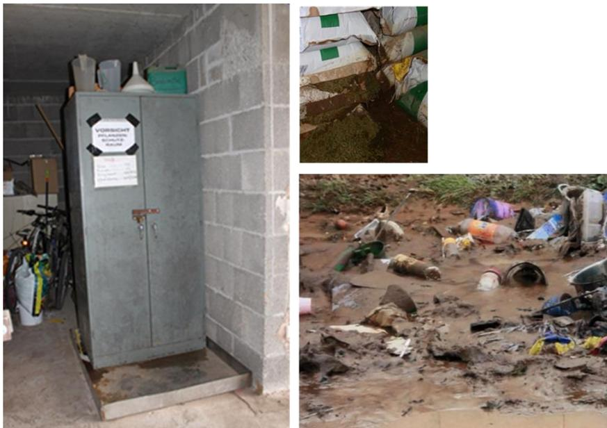
Pflanzenschutzmittel gelten als stark wassergefährdend und unterliegen der Gefahrstoffverordnung. An ihre Lagerung müssen hohe Anforderungen gestellt werden. In Betrieb befindliche Lagerstätten müssen so ausgebildet werden, dass kein Hochwasser eindringen kann und keine Schadstoffe austreten können.
