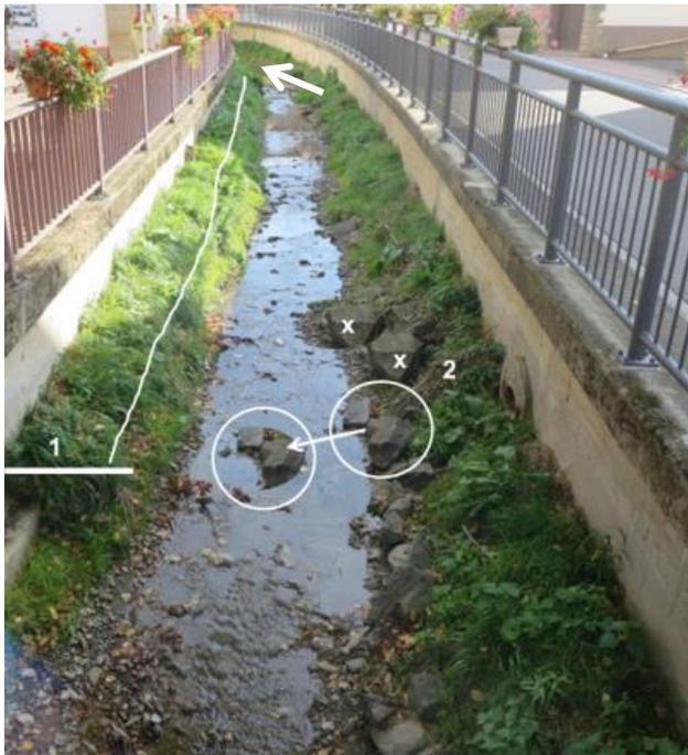
Durch eine zielgerichtete Gewässerunterhaltung sollten die Anlandungen im Hochwasserabflussprofil entfernt (1) und die vorhandenen Steine im Niedrig- und Mittelwasserprofil strukturbildend (2) umgelagert werden.
