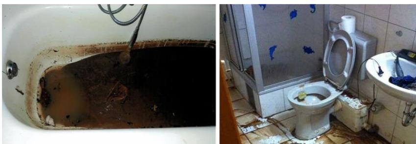
Dieser Rückstau bis auf das Niveau der Straßenoberkante (Rückstauenebene) ist in allen Kommunen satzungskonform und muss von den Nutzern eingeplant werden. Jeder Hausei-
