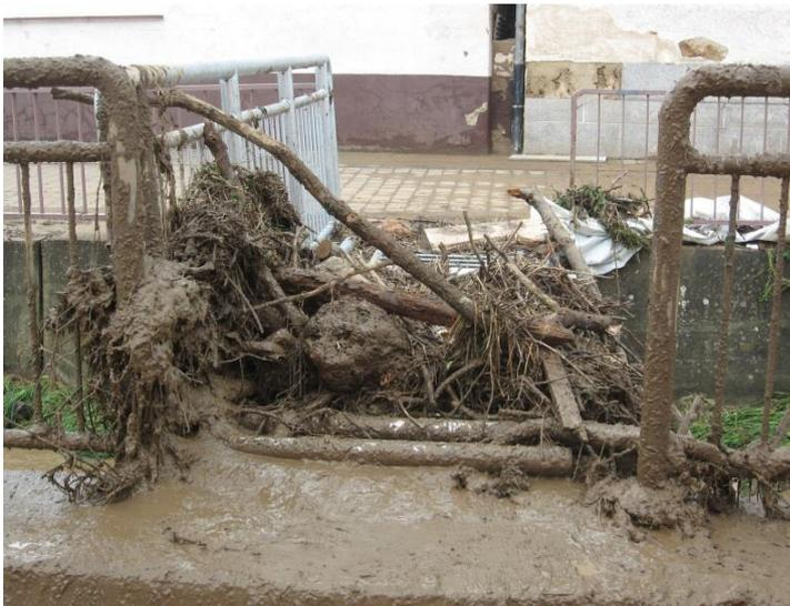
Der Fußgängersteg über die Moschel im Unterdorf stellt eine Engstelle dar und hier besteht immer die Gefahr einer frühzeitigen Verklausung. Im September 2014 wurde das Gelände umgedrückt. Hier wird empfohlen den Punkt als Einsatzstelle in den Alarm- und Einsatzplan der Feuerwehr aufzunehmen. Bei Hochwasser sollte hier versucht werden, den Abflussquerschnitt so lange wie möglich freizuhalten.
