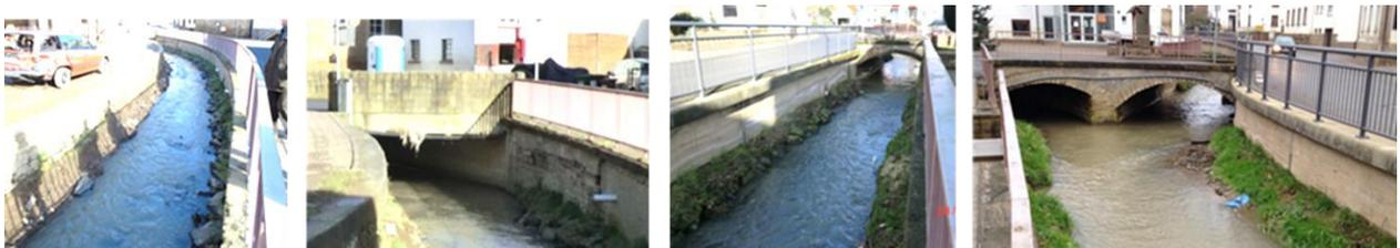
Lediglich unter dem Fußgängersteg im Unterdorf (Bild unten Mitte) kann rechnerisch nur etwa ein HQ10 bis HQ25 abfließen.
