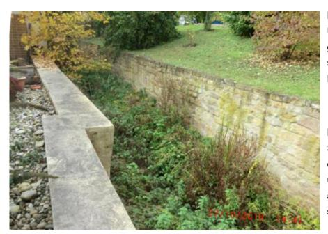
Dort fließt er in einem mit Ufermauern massiv ausgebauten Gerinne zwischen hausnahen Gärten. Das Längsgefälle ist hoch.
