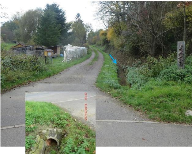
Durch Aufweitung des Einlaufbereiches, Anordnung eines Kragens und ggf. eines Sandfangs mit Einlaufgitter könnte die Leistungsfähigkeit zwar erhöht werden, ein Überlaufen
