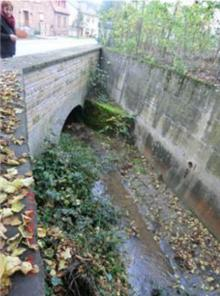
Dann verschwindet er in einer Verrohrung. Diese quert die Hauptstraße schräg und mündet in ein mit Gitterrosten abgedecktes Trennbauwerk.
