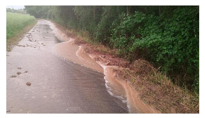
Gräben und Tiefenlinien sollten möglichst erosionssicher befestigt sein, z.B. mittels Grünstreifen und nicht ackerbaulich genutzt werden.
