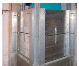
kann der Aufstellraum abgeschottet oder das Gerät wasserdicht eingehaust werden. Außerdem kann bei Installation geeigneter Pumpen an den Gebäudetiefpunkten über eine gewisse Zeit das eindringende Hochwasser abgepumpt werden, sofern die Stromversorgung während des Ereignisses nicht beeinträchtigt wird.
