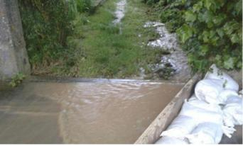
Bei dem letzten Hochwasser wurde auf der Straße eine Sperre aus einem Brett, das von Sandsäcken gestützt wurde errichtet. Diese war so ausgerichtet, dass das zufließende Wasser gezielt
