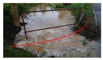
Um bei auflaufender Hochwasserwelle ein frühzeitiges Ausufern zu verhindern sollte ein sog. Kragen beispielsweise in Form einer Mauer zur Straße hin angeordnet werden.
