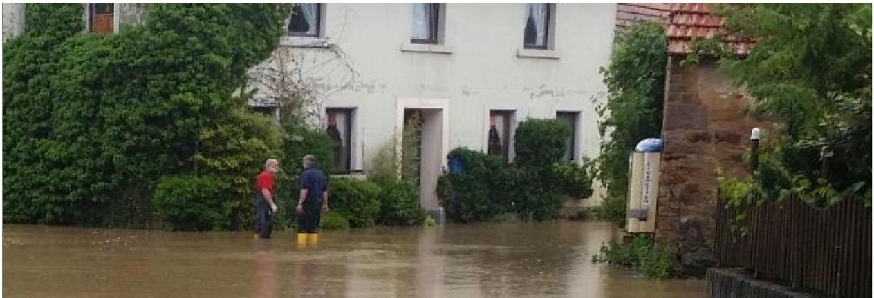
Dabei kann Hochwasser über unterschiedliche Wege in Gebäude gelangen bzw. auf diese einwirken: Hochwasser kann durch tiefliegende, nicht überflutungssichere Gebäudeöffnungen, also Hauseingänge und Fenster einströmen.
