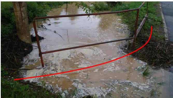
Um bei auflaufender Hochwasserwelle ein frühzeitiges Ausuferen zu verhindern sollte ein sog. Kragen beispielsweise in Form einer Mauer zur Straße hin angeordnet werden.
