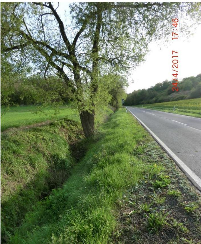
Unterhalb des Weges folgt wieder ein offener Graben, in der der Baum im Abflussprofil ebenfalls ein Abflusshindernis darstellt. Ufert der Graben aus, läuft Wasser auf die K 26, aber auch wieder zurück in den Graben. Die Situation an dieser Stelle könnte am ehesten entspannt werden, indem der Durchlass durch eine Furt ersetzt wird und der Graben unterhalb leistungsfähiger ausgebaut wird.
