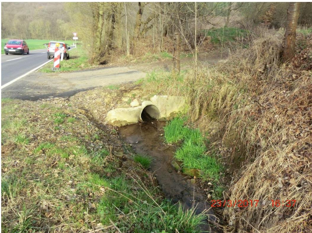
Der Wegdurchlass wird ungünstig angeströmt und er verstopft leicht, da aus dem Einzugsgebiet sehr viel Geröll und Geäst antransportiert wird.
