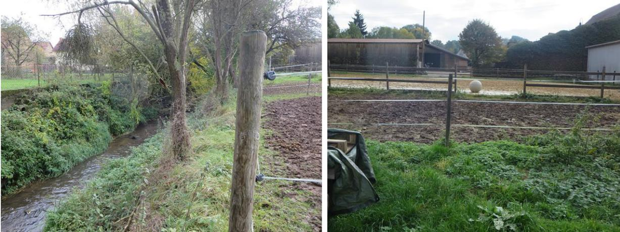
Oberhalb der Brücke Langgasse reicht die Bebauung bis an den Bach und bildet einen Querriegel. Dadurch wurde die auf dem Vorland strömende Flutwelle am Weiterfließen gehindert und die bachnahen Grundstücke und die tiefliegenden Gebäudeteile wurden überschwemmt. Hochwasser drang in Garagen, Nebengebäude und Wohnbereiche ein.
