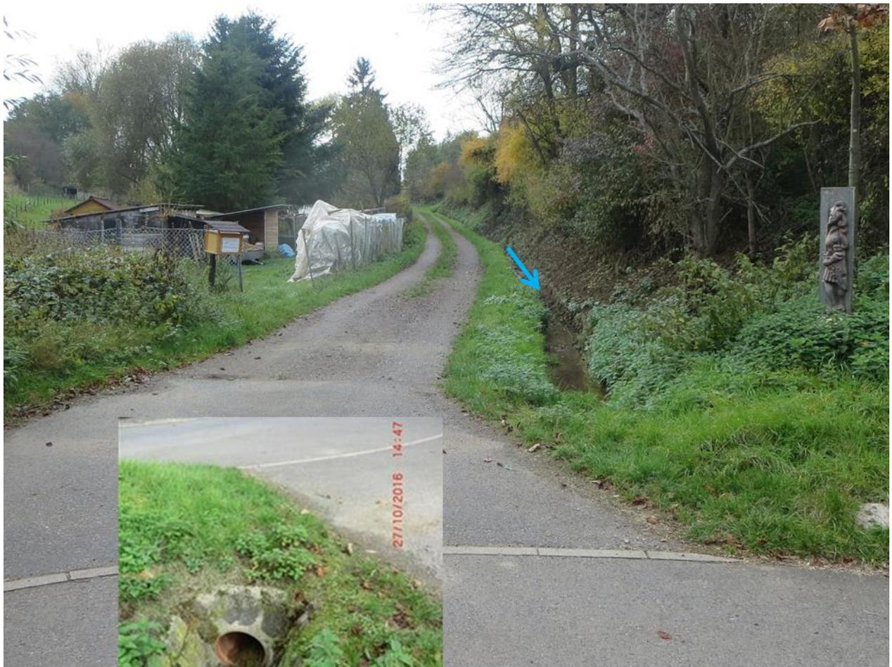
Durch Aufweitung des Einlaufbereiches, Anordnung eines Kragens und ggf. eines Sandfangs mit Einlaufgitter könnte die Leistungsfähigkeit zwar erhöht werden, ein Überlaufen
