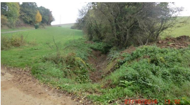
schreitender Erosion bei der der Weg unterspült wurde. Der Graben oberhalb war völlig verschlammmt und wurde nach dem Schadensereignis neu ausgehoben.
