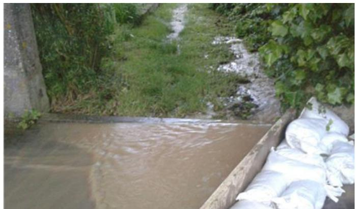
Bei dem letzten Hochwasser wurde auf der Straße eine Sperre aus einem Brett, das von Sandsäcken gestützt wurde errichtet. Diese war so ausgerichtet, dass das zufließende Wasser gezielt
