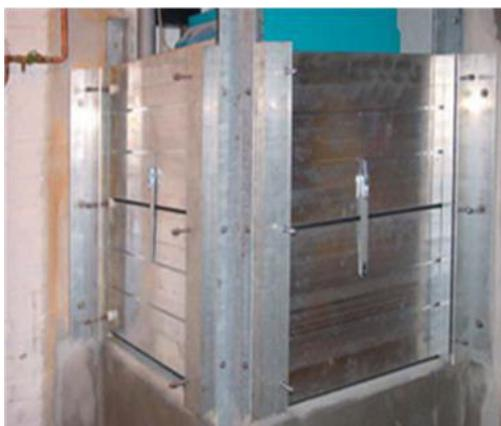
kann der Aufstellraum abgeschottet oder das Gerät wasserdicht eingehaust werden. Außerdem kann bei Installation geeigneter Pumpen an den Gebäudetiefpunkten über eine gewisse Zeit das eindringende Hochwasser abgepumpt werden, sofern die Stromversorgung während des Ereignisses nicht beeinträchtigt wird.
