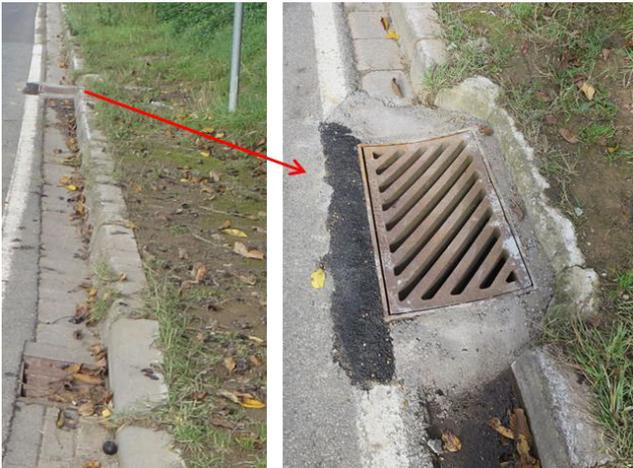
Die Straßenabläufe sitzen nicht am Tiefpunkt und ermöglichen keine zügige Entwässerung der Straße. Bei den Starkregenereignissen 2014 und 2016 bildete sich auf der Straße ein See mit Schlammwasser und der Verkehr war gefährlich behindert. Die Reinigungsarbeiten dauerten noch Tage nach den Schadensereignissen an.
