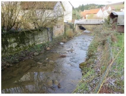
Das Abflussprofil der Moschel in Sitters ist aufgrund der Breite und Tiefe sowie des gleichmäßigen und glatten Trapezprofils sehr leistungsfähig. Zudem hat sich das Bachbett bei dem Hochwasserabfluss 2014 an der Sohle freigespült. Aktuell besteht innerhalb der Ortslage kein Handlungsbedarf.
