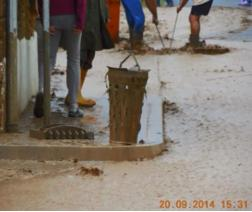
Während Hochwasserereignissen werden immer wieder von Anliegern Kanaldeckel und Straßenablaufabdeckungen einschließlich der Schmutzfänger herausgenommen. Dadurch entsteht eine Gefahrenstelle und für den Verursacher ein Haftungsrisiko (s. auch Abschnitt 10.6.2). Durch
