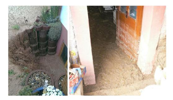
Im Bild unten ist ein ungesicherter, außenliegender Kellerabgang gezeigt. Hier drang Hochwasser ein, füllte den Kellerraum und drückte von unten die Kellerdecke hoch. Der Fußboden des darüberlegenden Wohnraumes wurde von unten zerstört.
