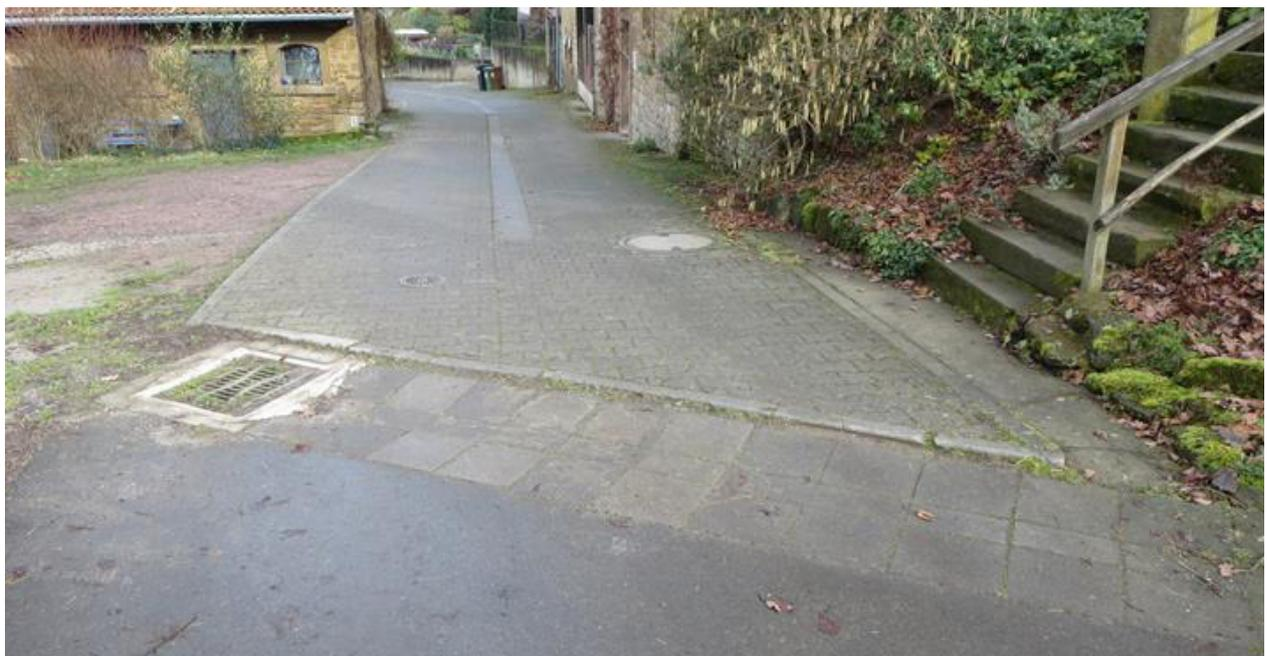
Dies traf zum Zeitpunkt der Bearbeitung des Pilotprojektes beispielsweise für die Querrinne und den Einlauf am Übergang des Mühlweges in den Außenbereich zu. Hier besteht leicht die Gefahr, dass das Entwässerungssystem überströmt wird und Wasser auf dem Mühlweg in die Ortslage fließt. Durch eine leistungsfähigere Querrinne könnte das Außengebietswasser sicherer von der Ortslage ferngehalten werden.
