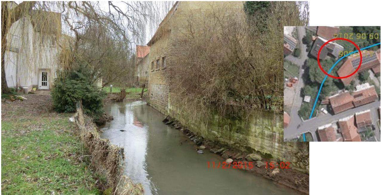
Im Ortskern ist die Moschel beidseitig mit Ufermauern gefasst und mit einer Breite von etwa 6 m relativ großzügig ausgebaut. Die Hauptstraße quert den Bach über eine Einfeldbrücke.
