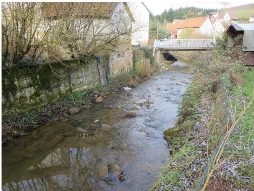
Das Abflussprofil der Moschel in Sitters ist aufgrund der Breite und Tiefe sowie des gleichmäßigen und glatten Trapezprofils sehr leistungsfähig. Zudem hat sich das Bachbett bei dem Hochwasserabfluss 2014 an der Sohle freigespült. Aktuell besteht innerhalb der Ortslage kein Handlungsbedarf.
