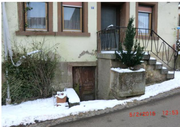
Straße die Wasserführung in Form von Bordsteinen fehlt. Bei Häusern, die in der klassischen Bauweise der Region errichtet sind, besteht dadurch die große Gefahr, dass Wasser über tiefliegende Kellertüren in Keller eindringt. Alte Keller können bei hochwasserverträglicher Nutzung zwar ohne Probleme getrocknet werden. Es besteht jedoch die Gefahr, dass bei Wasserständen bis zur Decke alte Holzbalkendecken hochgedrückt werden (s.
