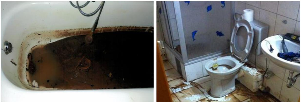
Dieser Rückstau bis auf das Niveau der Straßenoberkante (Rückstauenebene) ist in allen Kommunen satzungskonform und muss von den Nutzern eingeplant werden. Jeder Hauseigentümer ist verpflichtet, sich gegen Rückstau aus der Kanalisation durch Einbau von geeigneten Rückstaueinrichtungen zu schützen. Wenn es viel regnet oder wenn die Bäche Hochwasser führen, kann es auch zum Überstau aus der Kanalisation auf die Straße kommen.
