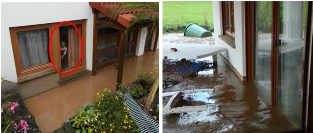
Die Gefahr, dass eine Scheibe dem Wasserdruck nicht Stand hält, ist sehr groß. Im Untersuchungsgebiet wurde eine Frau in ihrer Wohnung durch die eindringende Flutwelle von schwimmendem Mobiliar eingeklemmt.
