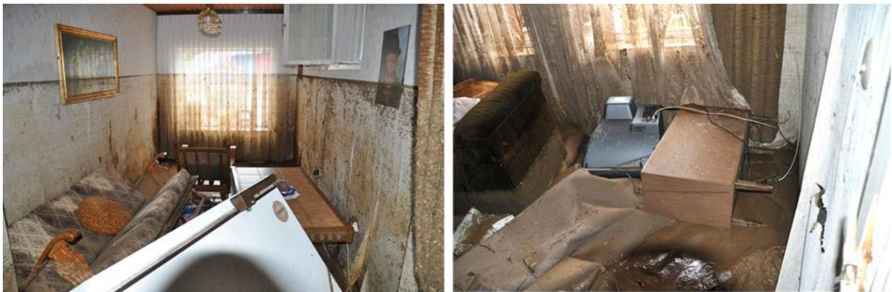
Dringen Wasser und Schlamm in Gebäude ein, kann es zu irreversiblen Schäden an der Ausrüstung z.B. an Türen, Fenstern, Haustechnik, Putz, Tapeten, Bodenbelägen sowie an der Inneneinrichtung kommen. In Extremfällen wird auch die Standsicherheit des Gebäudes gefährdet.
