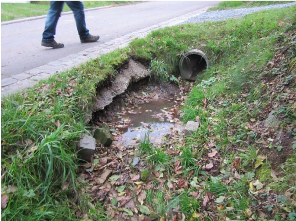
Auch an in dem anschließenden öffentlichen Grabensystem kam es zu Auskolkungen und Erosionen, Schäden an der Straße sind dabei glücklicherweise keine entstanden.
