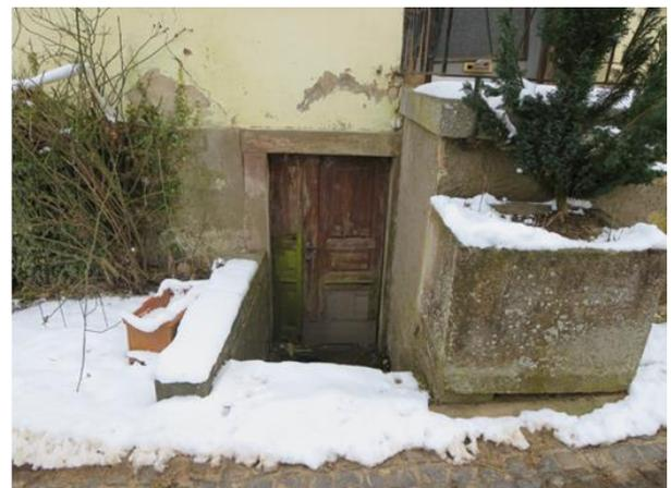
Im Bild unten ist ein ungesicherter, außenliegender Kellerabgang gezeigt. Hier drang Hochwasser ein, füllte den Kellerraum und drückte von unten die Kellerdecke hoch. Der Fußboden des darüberliegenden Wohnraumes wurde von unten zerstört.
