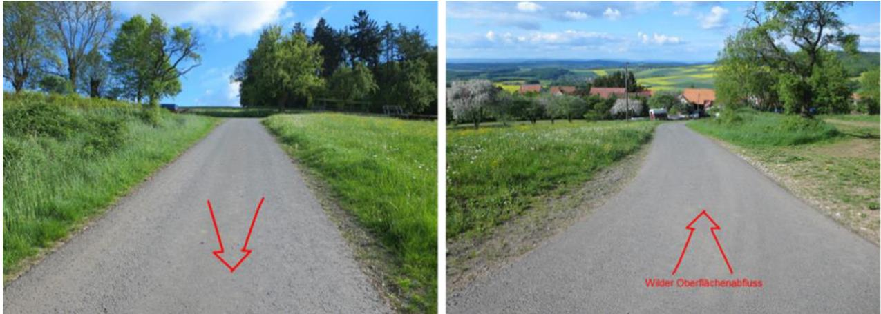
Am Übergang vom Außenbereich zum Ortsrand verläuft auf der Bergseite (Innenkurve) ein Graben, der im Bereich einer Grundstückszufahrt verrohrt ist. Einlaufseitig ist ein Gitterrost, der von oben angeströmt wird, angeordnet. Der Einlauf kann sich schnell zusetzen, dann fließt Wasser auf der Ortsstraße zur Ortsmitte.
