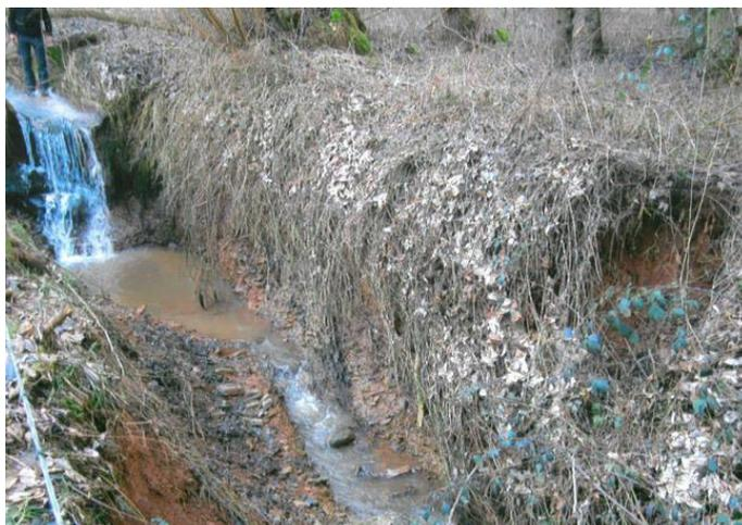
Erhebliche Schadstrukturen sind durch Hochwasser im Ransbach unterhalb von Schönborn und unterhalb der Einleitstelle der Regenwasserkanalisation entstanden. Hier hat sich der Bach extrem in die Tiefe eingegraben.
