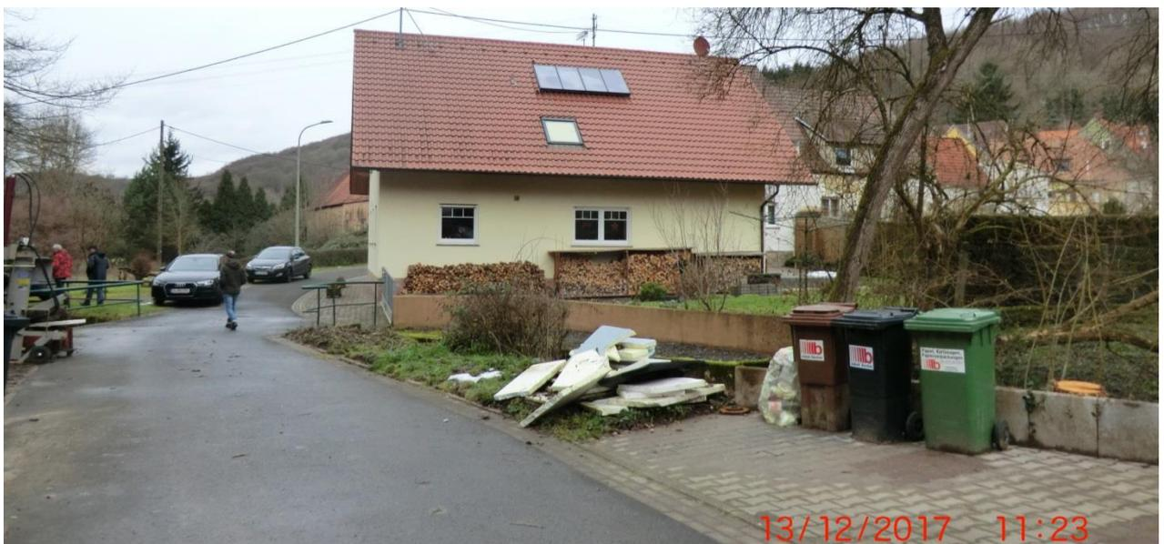
An Haus Nr. 3A wurden bereits Objektschutzmaßnahmen umgesetzt. Die Mauer soll Hochwasser des Hahnenbachs vom Gebäude abhalten. Auch das Einfahrtstor ist im unteren Teil wasserabweisend ausgebildet.
