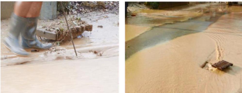
Generell kann es durch das Herausnehmen von Kanaldeckeln zu gefährlichen Situationen kommen. Werden zusätzlich zu den Deckeln auch die Schmutzfänger mit herausgenommen, werden hohe Schmutzfrachten in die Kanalisation eingebracht.
