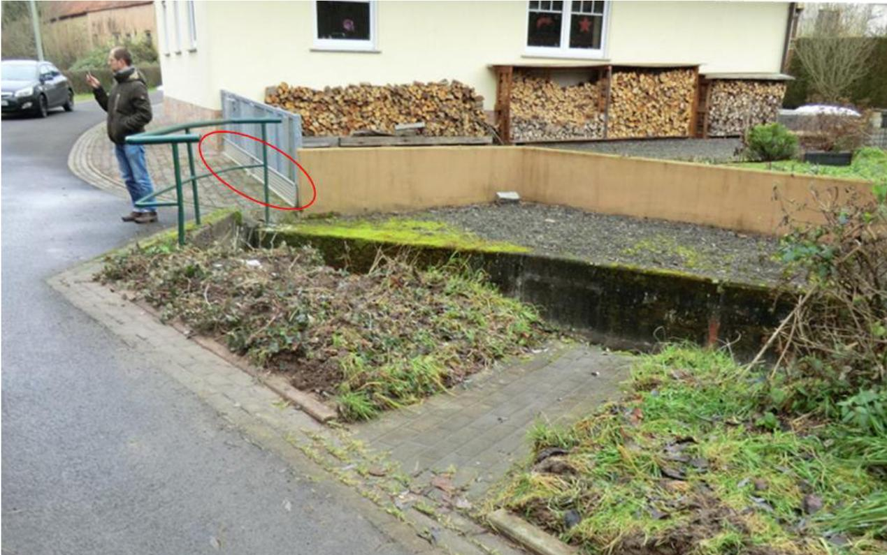
Bei einem Ereignis wie 2014 in Ransweiler wird die Hochwasserwelle jedoch vermutlich die Mauer überströmen und auch das am Haus gestapelte Brennholz auftreiben und abtransportieren.
