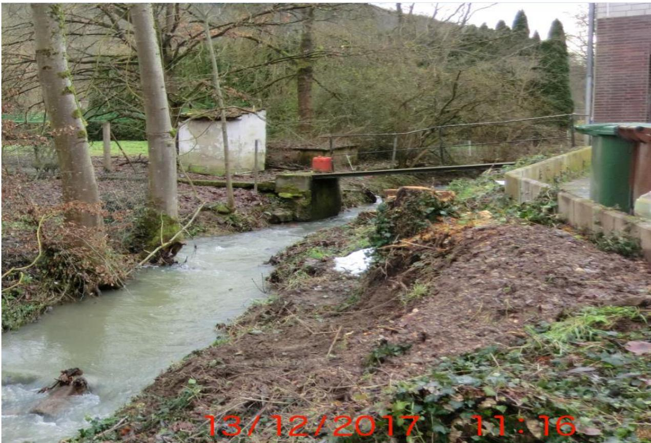
Neben der Verlegung des Bachbetts, müsste die Böschung am Haus naturverträglich gesichert und der abflussbehindernde Steg sowie Bauten im 10 m-Bereich des Hahnenbachs müssten entfernt werden.
