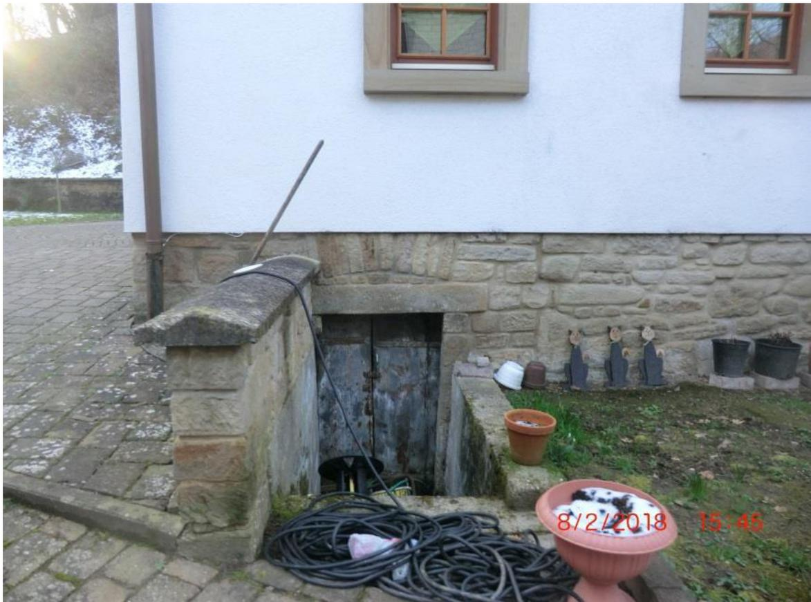
Im Bild unten ist ein ungesicherter außenliegender Kellerabgang in Waldgrehweiler gezeigt. Hier drang Hochwasser ein, füllte den Kellerraum und drückte von unten die Kellerdecke hoch. Der Fußboden des darüberliegenden Wohnraumes wurde von unten zerstört.
