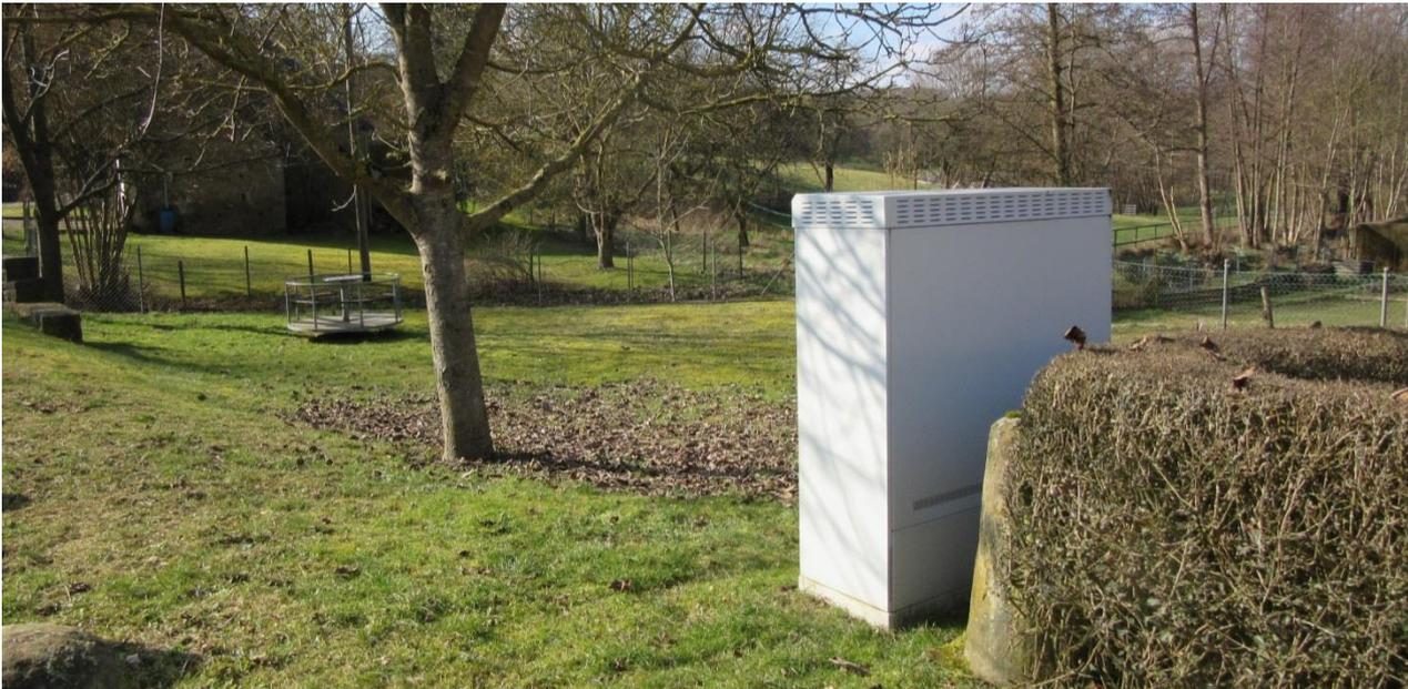
Es wird empfohlen den Verteilerkasten mit einem Anprallschutz zu versehen. Zudem sollte auch dieser der Punkt in den Alarm- und Einsatzplan der Feuerwehr aufgenommen werden.
