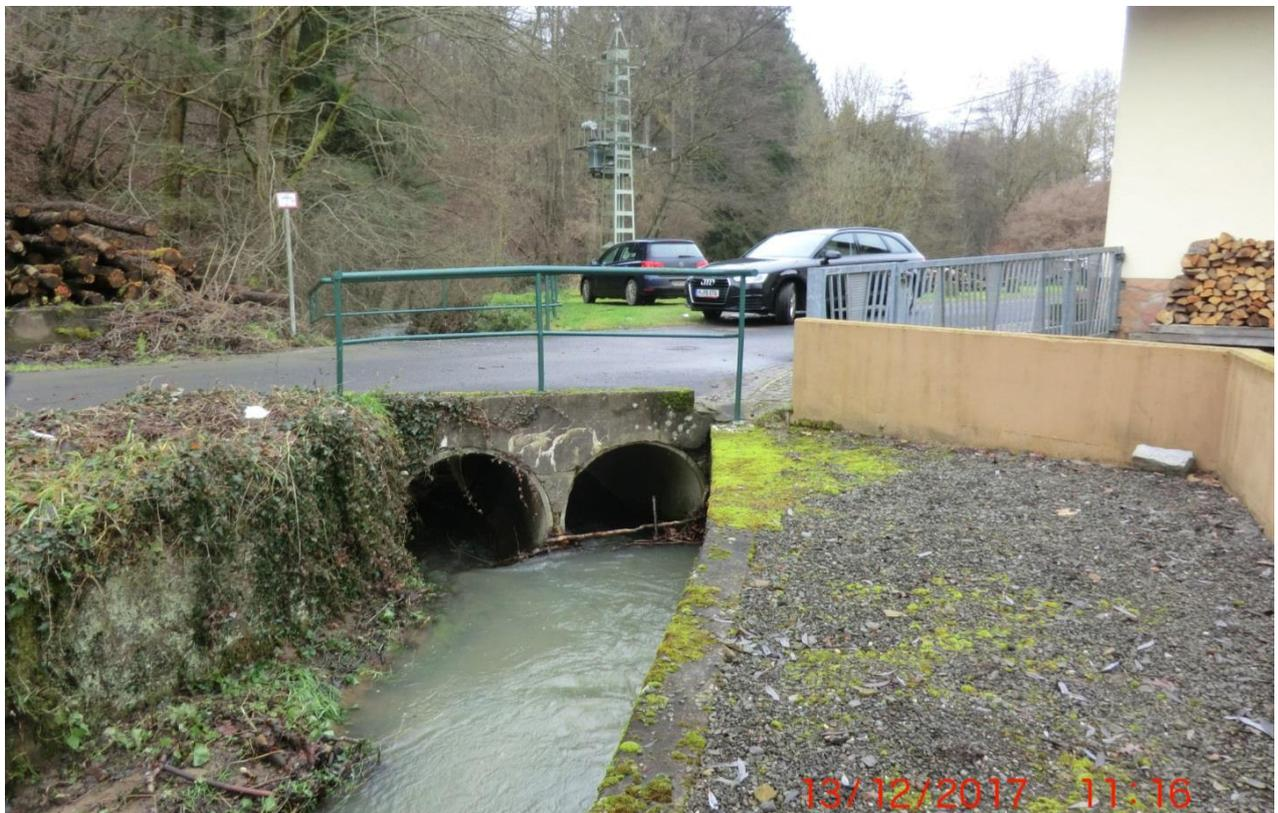
An der Brücke Kirchenstraße in Rudolphskirchen kann bei Hochwasserabfluss das Wasser an den Brüstungsmauern vorbei strömen und unterhalb der Straße wieder der Talsohle zufließen. Durch die Geländer und die höhere Mauer in der Mitte der Brücke kommt es jedoch zu Behinderungen und Turbulenzen, die zu einem Aufstau oberhalb führen.
