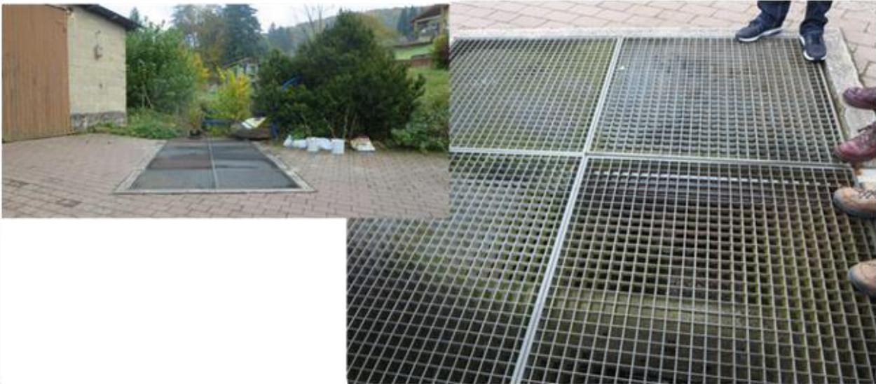
Das Einlaufbauwerk in die Verrohrung des Kändelgrabens ist als großer Geröllfang ausgebildet, der bei den bisher aufgetretenen Hochwasserereignissen sehr gut als solcher funktioniert hat. Die aus dem Bauwerk weiterführende Verrohrung war bei den Ereignissen jedoch so voll, dass in der Amtsstraße Schachtdeckel herausgedrückt wurden. Da die Verrohrung den Abfluss begrenzt, macht es keinen Sinn den Geröllfang leistungsfähiger umzubauen.
