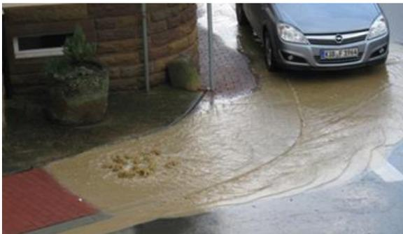
Dieser Rückstau bis auf das Niveau der Straßenoberkante (Rückstauenebene) ist in allen Kommunen satzungskonform und muss von den Nutzern eingeplant werden. Jeder Hauseigentümer ist verpflichtet, sich gegen Rückstau aus der Kanalisation durch Einbau von geeigneten Rückstaueneinrichtungen zu schützen.
