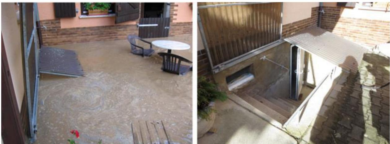
Im Bild oben ist ein ungesicherter außenliegender Kellerabgang gezeigt (Beispiel aus Waldgrehweiler). Hier drang Hochwasser ein, füllte den Kellerraum und drückte von unten die Kellerdecke hoch. Der Fußboden des darüberliegenden Wohnraumes wurde von unten zerstört.
