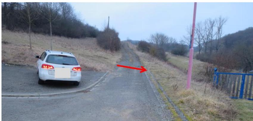
Hier wird empfohlen zwei Querschläge (rote Pfeile) einzubauen, um das oberflächlich abfließende Wasser in die angrenzende Fläche und zum Kändlergraben abzuschlagen.
