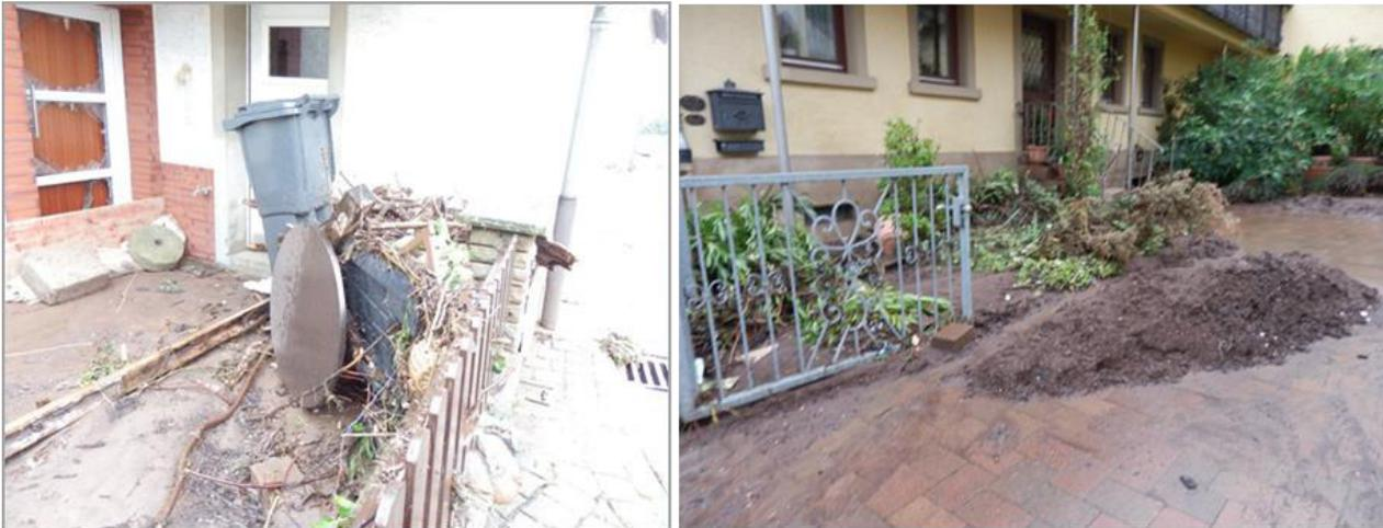
Das Gelände des Anwesens Buschengasse 2 wirkte als Rechen für angeschwemmtes Treibgut. Da das Tor gegen die Fließrichtung öffnet, wurde es durch das Hochwasser nicht aufgedrückt und konnte auch nicht geöffnet werden. Das Hochwasser staute sich oberhalb auf dem Hof und drang in die Keller ein. Das Gelände wirkte zudem als Treibgutrechen. Das Erdgeschoss des Anwesens lag auch bei dem Extremereignis hoch genug und wurde nicht von Hochwasser erreicht.
