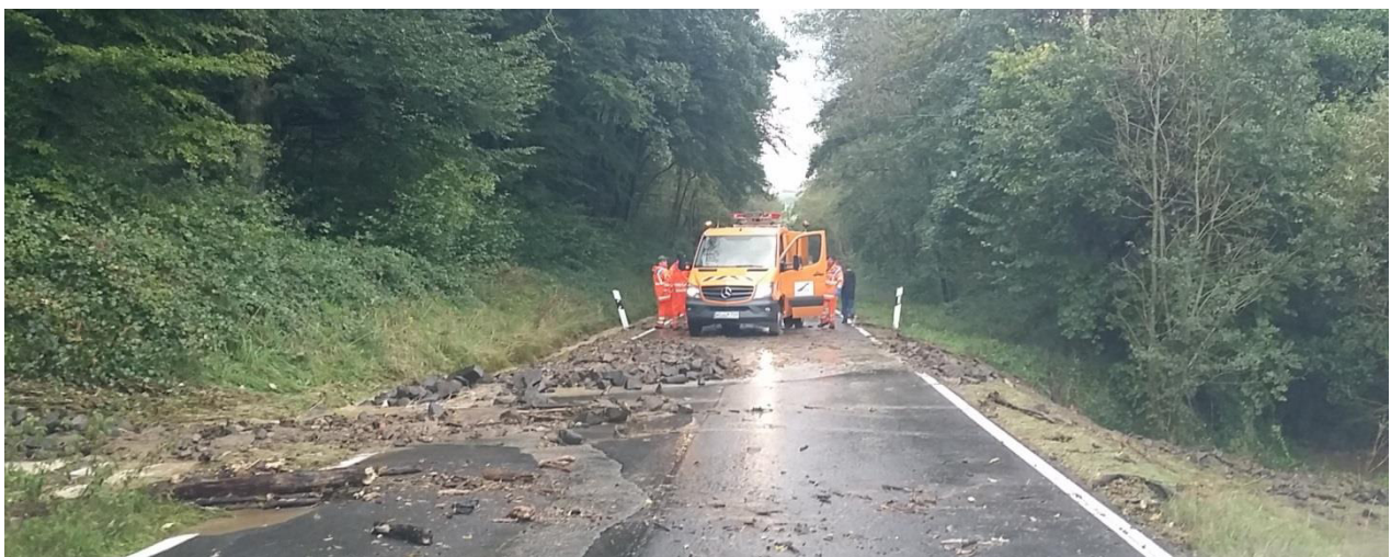
Erosionsschäden im Moscheltal am 20. September 2018
