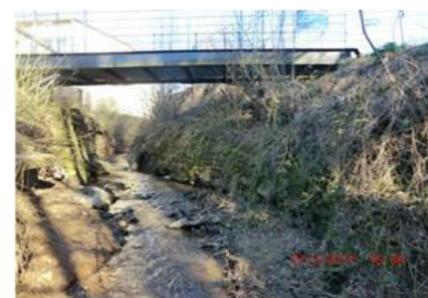
Der Gerbach wurde im Zuge der Erschließung der Sportanlage aus seiner ursprünglichen Trasse verlegt und er verläuft heute eingezwängt und massiv verbaut zwischen Halle und Sportplatz.
