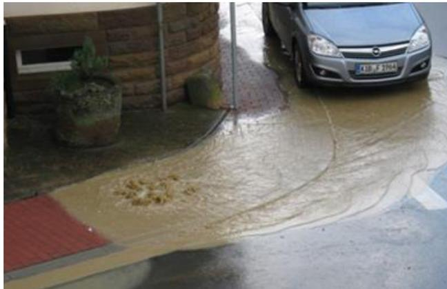
Dieser Rückstau bis auf das Niveau der Straßenoberkante (sog. Rückstauenebene) ist in allen Kommunen satzungskonform und muss von den Nutzern eingeplant werden. Jeder Hauseigentümer ist verpflichtet, sich gegen Rückstau aus der Kanalisation durch Einbau von geeigneten Rückstaueneinrichtungen zu schützen. Wenn es jedoch viel regnet oder wenn die Bäche Hochwasser führen, kann es
