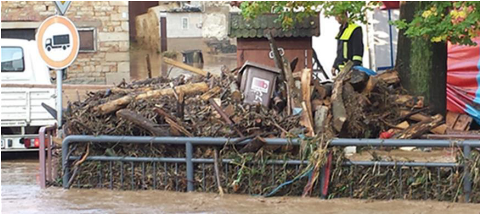
Brückengeländer als Treibgutfänger 2014 in Waldgrehweiler
