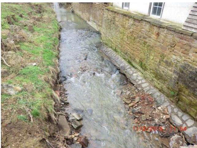
Bei dem Hochwasser 2014 wurden in der Moschel Auflandungen an der Sohle von der Flutwelle erodiert und das Bachprofil wurde insbesondere unter den Brücken freigespült, so dass aktuell kein Handlungsbedarf zur Gewässerunterhaltung besteht.
