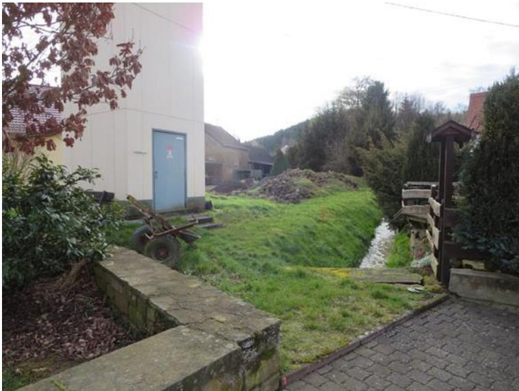
Als kritisch eingestuft wird die Lage der Transformatorstation unmittelbar neben dem Einlauf zur Mehrbachverrohrung. Diese war im September 2014 umflutet, der Strom war aber nach Aussage von Anliegern nicht ausgefallen. Wenn das Wasser weiter gestiegen wäre, hätte der Strom abgestellt werden müssen.
