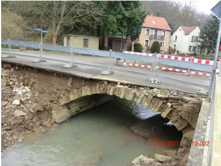
Die abgebildete Brücke Grubstraße wurde im September 2014 von der Flutwelle zerstört, sie muss neu gebaut werden.
