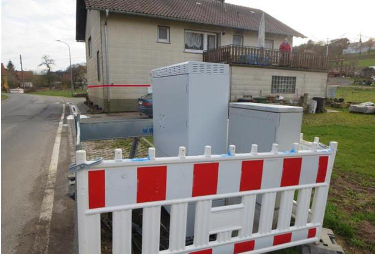
Ein Verteilerkasten der Telekom steht nach Aussage der Anlieger am tiefsten Punkt und wäre bei Hochwasser immer betroffen. Im September 2014 kam es partiell zum Ausfall des Festnetztelefons.
