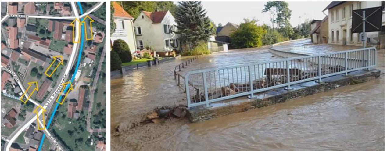
Silagebällen verstopften temporär den Brückendurchlass Grubstraße und Polderholz und anderes Schwemmgut verfangen sich im Stabgeländer der Brücke. Das Wasser staute sich und der Staudruck kippte das Geländer mit der Fundamentierung um.
