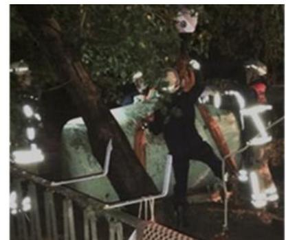
Oberirdische Gastanks müssen gemäß einschlägiger Vorschriften zur Aufstellung (TRB 600 - Technische Regeln Druckbehälter) so geschützt werden, dass sie weder von der Flutwelle weggerissen, noch aufschwimmen oder durch Treibgut beschädigt werden können. Am besten werden die Tanks außerhalb der überschwemmten Bereiche aufgestellt.
