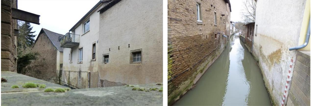
Im weiteren Verlauf bis zur Brücke „Auf der Au“ ist der Bach geradlinig als Trapezprofil ausgebaut, bereichsweise dienen Gartenmauern als Ufermauern.
