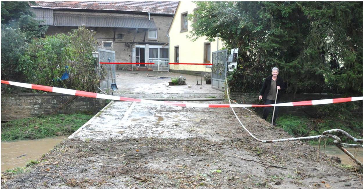
Die Zufahrt zu dem Bauernhof ist häufiger von Überflutungen betroffen. Da die Brücke jedoch nur aus einer Platte besteht und kein enges Stabgeländer hatte, bot sie vergleichsweise wenig Fließwiderstand. Sie wurde bisher bei Hochwasser unter- und überströmt ohne dass größere Schäden an dem Bauwerk und im Umfeld auftraten.
