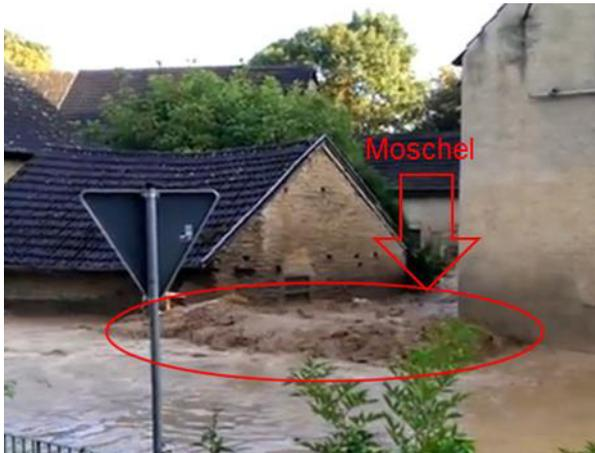
Im September 2014 drosselte die Brücke in der Lindenstraße den Abfluss und es kam oberhalb zum Aufstau und zu einer flächigen Überflutung des Ortsteils. Beim höchsten Hochwasserstand wurde die Brüstungsmauer der Lindenstraße im Oberwasser überströmt (Bild links, rotes Oval).
