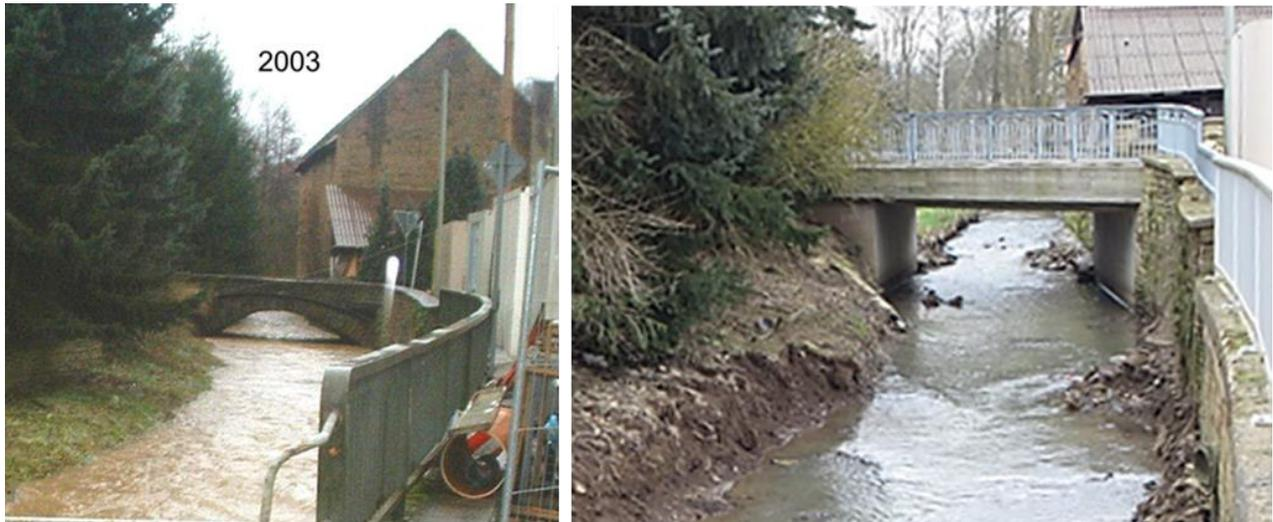
Die Brücke „Auf der Au“ wurde zwischen 2003 und 2011 von einer Bogenbrücke in eine moderne Einfeldbrücke mit größerem Abflussvermögen umgebaut. Unterhalb der Brücke verläuft auf der linken Bachseite die Hauptstraße. Dann quert eine private Überfahrt.
