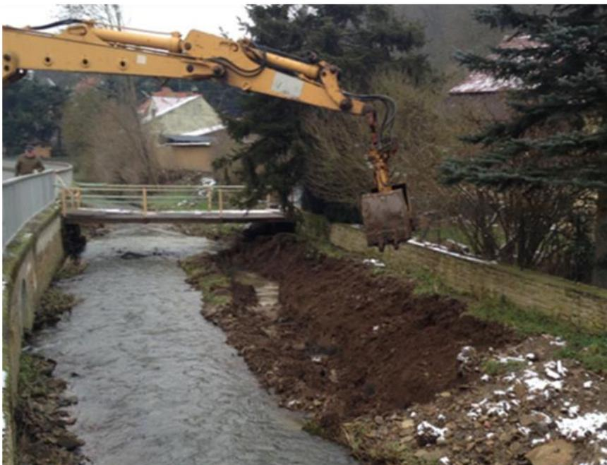
Im Nachgang zu dem Hochwasser wurden in Finkenbach-Gersweiler umfangreiche Unterhaltungsmaßnahmen durchgeführt und die im Laufe der Jahre stark aufgelandete Berme am Ufer entfernt.
