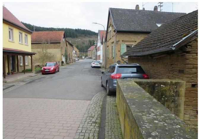
In Finkenbach-Gersweiler fehlt in der Lindenstraße ein Notentlastungsweg, was im September 2014 zu einer Verstärkung der Schäden führte. Der Hochwasserabfluss wird oberhalb der Lindenstraße durch einen Gebäuderiegel stark gebremst. An der Lindenstraße behindert die Brüstungsmauer der Moschelbrücke den Abfluss.
