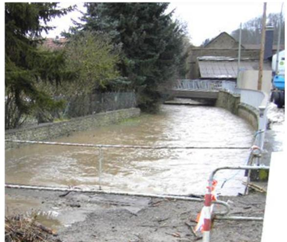
Die alte Bogenbrücke wurde nach dem Hochwasser 2003 durch eine größere Brücke ersetzt. Dennoch wurden durch die enormen Fließgeschwindigkeiten in der Moschel die Anlandungen an der Bachsohle auch insbesondere unter der Brücke erodiert. Die Auflandungen im Böschungsbereich der Moschel waren generell stabil und auch nach dem Hochwasser noch vorhanden.
