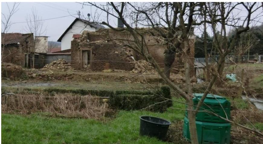
Durch die Flutwelle wurde oberhalb der Brücke „Auf der Au“ ein altes landwirtschaftliches Gebäude weiter zum Einstürzen gebracht. Hier und in vergleichbaren Fällen sollte geprüft werden, ob solche ungenutzten, besonders hochwassergefährdeten Gebäude entfernt werden können.
