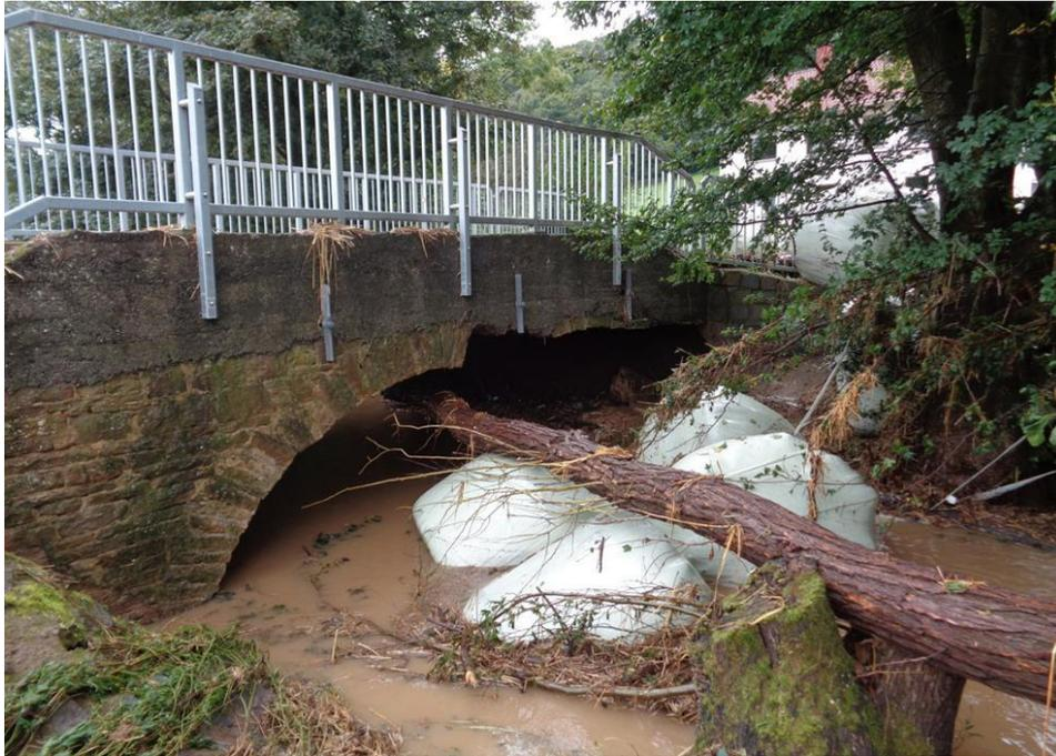
Unter der Brücke sammelten sich im September 2014 Silageballen und verstopften den Abflussquerschnitt. Durch die angreifenden Kräfte wurde die Brücke zerstört und sie muss neu gebaut werden.
