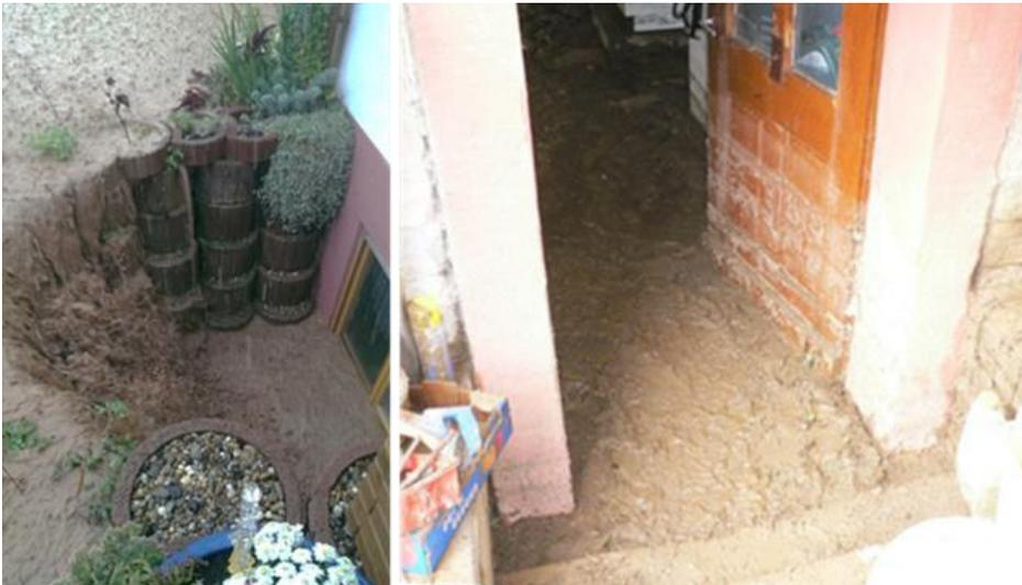
Im Bild unten ist ein ungesicherter außenliegender Kellerabgang gezeigt. Hier drang Hochwasser ein, füllte den Kellerraum und drückte von unten die Kellerdecke hoch. Der Fußboden des darüberliegenden Wohnraumes wurde von unten zerstört.
