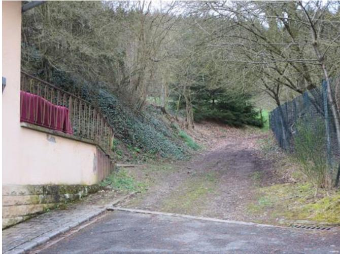
Leistungsfähigkeit und auf einen normalen Straßeneinlauf. Da es in Verbindung mit Starkregen immer auch zu Bodenerosion und je nach Jahreszeit und Disposition zu Geschwemmsel- und Gerölleintrag kommen kann, besteht hier grundsätzlich ein Gefahrenpunkt. Mit zunehmender Verschmutzung des Systems sinkt die Aufnahmekapazität.
