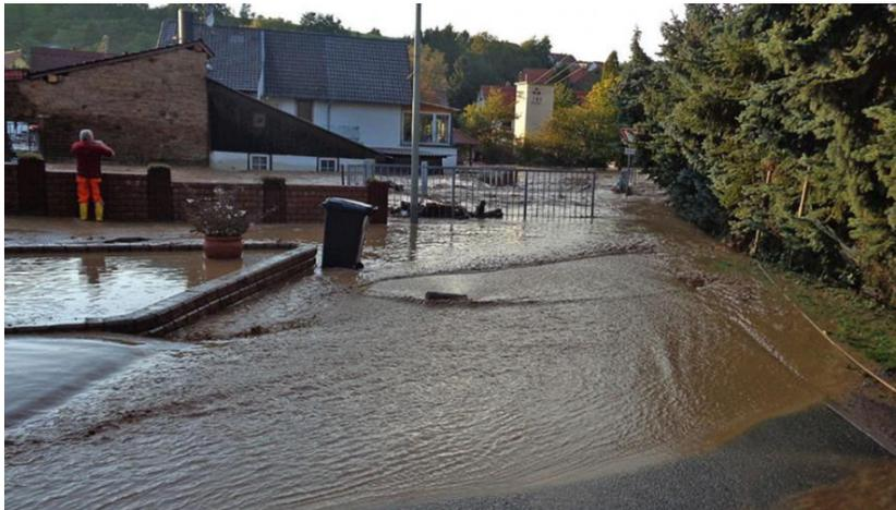
Auch die Brücke „Auf der Au“ war vollständig überflutet, obwohl die heutige Brücke einen größeren Fließquerschnitt hat, als die vorherige Bogenbrücke (vgl. Bilder Seite 11). In dem Stabgeländer der Brücke und in einem talquerenden Tor fing sich Treibgut. Später wurde das Tor zu dem Grundstück durch den Anströmdruck aufgedrückt
