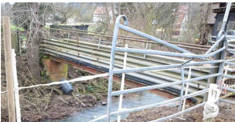
Gefahrenstellen können bei Hochwasser auch an abflussbegrenzenden Einbauten, wie dieser privaten Brücke entstehen. Insbesondere durch Treibgut (z.B. Silageballen) kann es hier zu Verklausungen kommen und Einbauten können weggerissen und abgetrieben werden.
