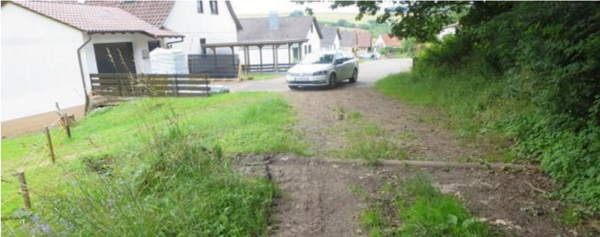
Am Schnittpunkt des Wegseitengrabens und der Querrinne ist ein Rohreinlauf zur Regenwasserkanalisation der Waldstraße angeordnet. Der Geländetiefpunkt der Koppel liegt deutlich tiefer als dieser Einlauf.
