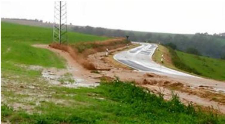
troffen sind. Gefährdet sind im Einflussbereich von Bachhochwasser existierende Anlagen. Am Abzweig der K8 von der L 386 schossen bei der Sturzflut im September 2014 Wassermassen an dem Stromgittermast vorbei. Schäden sind zwar keine bekannt, es wird jedoch empfohlen die Fundamente des Mastes gegen Erosion zu sichern.
