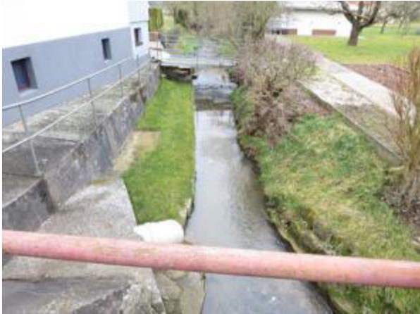
Unterhalb der Brücke Waldstraße münden von rechts der Wetzzenbach und von links der Regenwasserkanal aus der Waldstraße in den Dörnbach. Zudem quert wenige Metern unterhalb ein niedrigliegender Steg den Bach. Dadurch ist die hydraulische Situation generell ungünstig.
