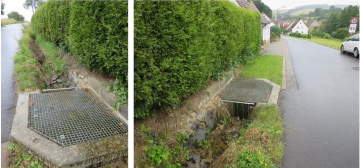
Um das Einlaufbauwerk möglichst lange funktionsfähig zu halten, werden folgende Maßnahmen empfohlen: Senkrecht einlaufgitter räumlich schräg stellen und nicht direkt aufsetzen, damit bei Verklausung ein Umströmen möglich ist. Betonbauwerk erhöhen, dass ein Kragen entsteht und die Sohle des zuführenden Grabens auf mehrere Meter pflastern. Bei der Wahl des Pflasters muss der Reinigungsaspekt im Vordergrund stehen.
