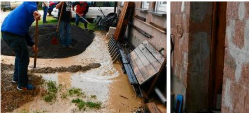
Hochwasser der Sturzflut oder Kanalarückstau kann in tiefliegende, nicht überflutungssicheren Keller- bzw. Untergeschosse, d.h. in alle unter dem Niveau des angrenzenden Geländes liegenden Gebäudeteile eindringen.
