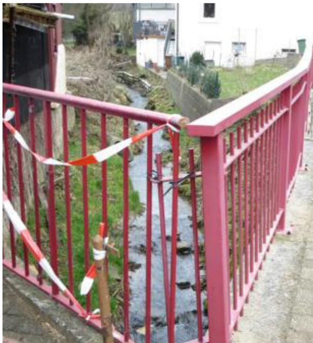
Das Geländer der Brücke „Am Lämmerwald“ wurde bei der Verkläuserung beschädigt. Stabgeländer auf Brücken und entlang von Bächen wirken wie Rechen für Treibgut. Dennoch werden keine umlegbaren Geländer empfohlen. Zwar wäre es vergleichsweise einfach, die technischen Voraussetzungen für umlegbare Geländer zu schaffen, es wären jedoch Regelungen zu treffen, wer die Gitter öffnen darf und wer verantwortlich ist, wenn dadurch jemand zu Schaden kommt.
