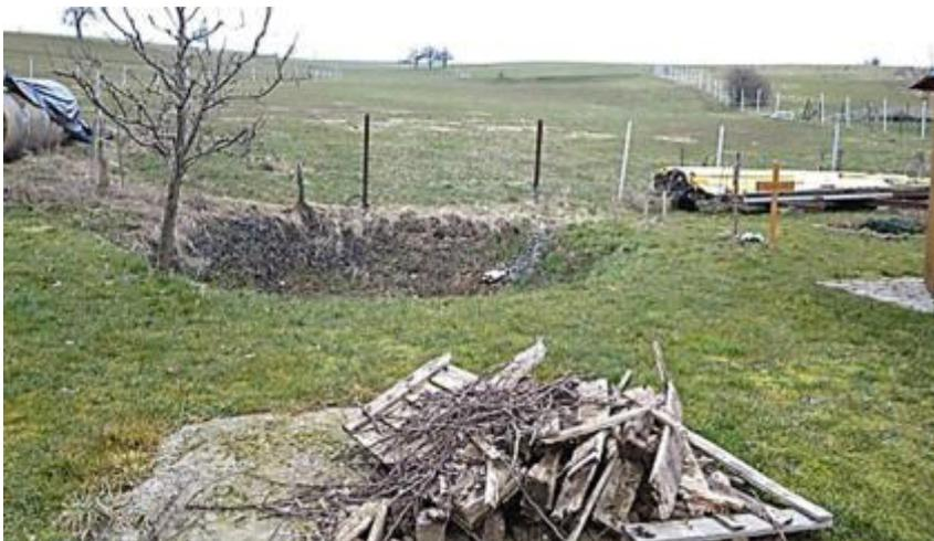
In dem Gebiet liegen mehrere Quellen und in der Tiefenlinie ist ein Felddrainagesystem verlegt, das im September 2014 bei weitem nicht den niedergegangenen Niederschlag aufnehmen konnte. Die Hauptdrainagen münden in einem Erdloch, das über eine Regenwasserleitung entleert wird, die quer über das
