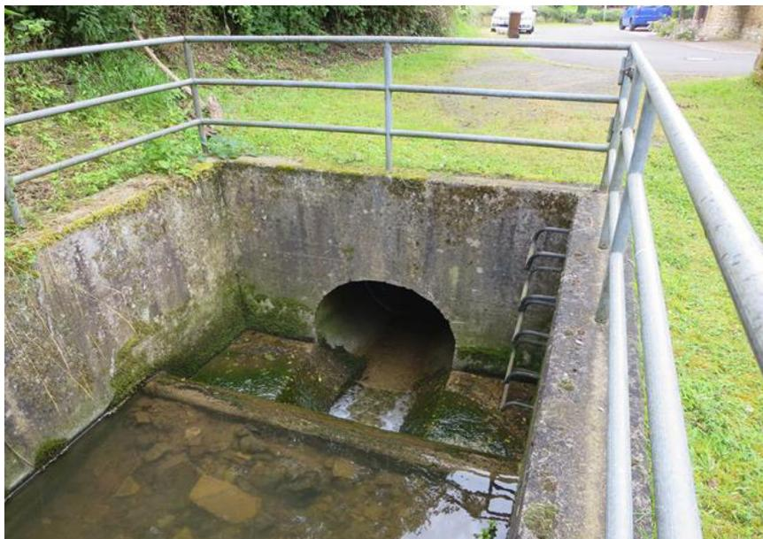
Der Geröllfang vor der Binsengrabenverrohrung hat eine eingeschränkte Leistungsfähigkeit. Ein Umbau wäre jedoch aufwändig und stünde in keinem Verhältnis zu den zu erwartenden Schäden.
