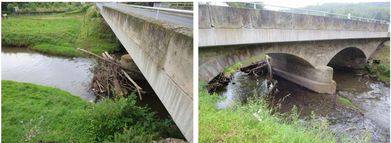
Die Alsenz ist, aufgrund des großzügigen Ausbauprofils, weniger anfällig gegen schnelle Verklausung. Das angeschwemmte Totholz im Bild oben wurde durch die Kreisverwaltung als Gewässerunterhaltungspflichtige kurzfristig entfernt.
