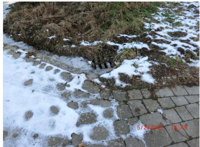
Dort ist am Ortsrand nur ein einfacher Straßeneinlauf angeordnet, der bei erhöhtem Oberflächenabfluss leicht überströmt wird. Sofern ein leistungsfähiger Kanal folgt, würde sich die Anordnung eines leistungsfähigeren Sand- und Geröllfangs anbieten.
