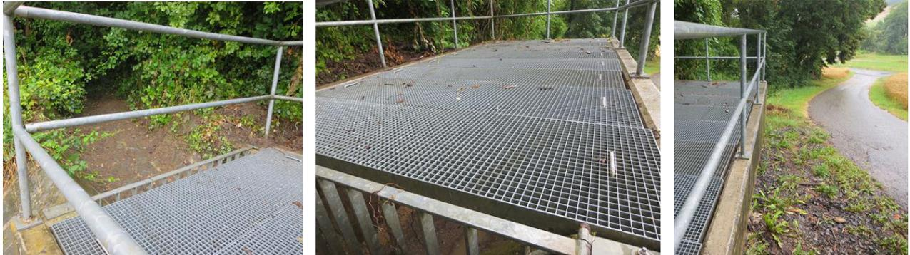
Das Einlaufbauwerk vom Waldgraben in die Verrohrung hat zwar ein sehr großes Volumen, die Eintrittsöffnung ist jedoch vergleichsweise klein. Bei einem Überstau kann auch Wasser über die Gitterrostabdeckung in das Bauwerk fließen. Aufgrund des fehlenden Kragens kann der Geröllfang jedoch auch leicht überströmt werden.
