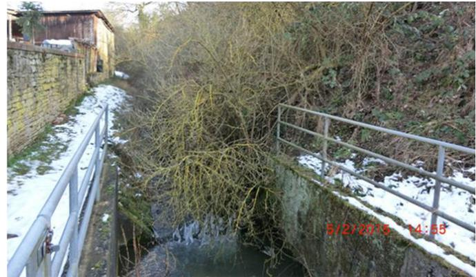
Das im Bach installierte Bauwerk ist in zwei Kammern aufgeteilt. Die zuerst durchflossene Kammer fungiert als Geröllfang, der aktuell stark gefüllt ist. Das zufließende Wasser fällt dann über die Trennmauer in die zweite Kammer und kann von hier in das weiterführende Rohr abfließen. Die Überfallschwelle des Geröllfangs liegt im oberen Drittel der weiterführenden Verrohrung. Das Bauwerk ist anfällig gegen Verkläuserung und hydraulische Überlastung.
