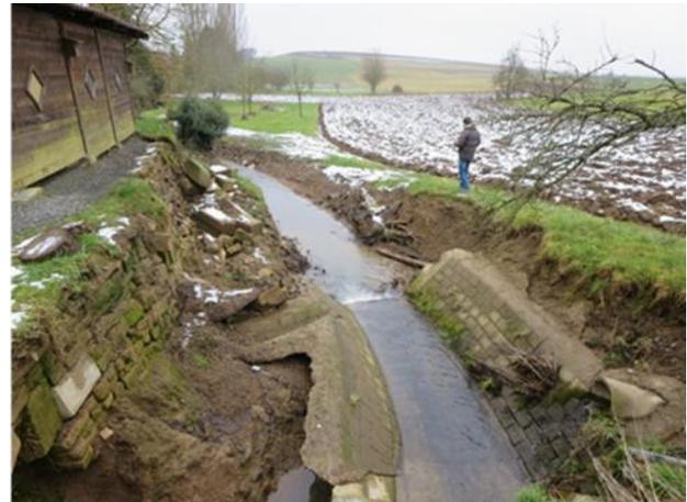
An der Brücke sind im September 2014 erhebliche Schäden entstanden. Augenzeugen zufolge soll auch ein Heuballen in der Leitplanke über dem Durchlass den Abfluss behindert haben. Das Durchlassrohr wurde teilweise freigespült und ein Teil der massiven Uferbefestigung wurde weggerissen. Die Brücke musste für den Verkehr gesperrt werden.
