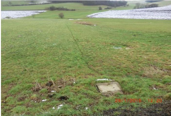
an vielen Stellen wenig geeignet, um das hier ankommende Oberflächenwasser geordnet aufzunehmen. Damit kann es leicht zu einem Überströmen mit wildem Oberflächenabfluss kommen. Es wird empfohlen, die Einläufe sukzessive leistungsfähiger auszubilden.
