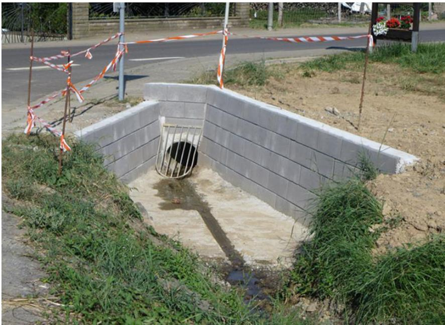
Von den empfohlenen Maßnahmen wurden Objektschutzmaßnahmen an den Nebengebäuden des Wohnbaugrundstücks Nr. 78 sowie der Umbau des Einlaufes bereits umgesetzt. Statt eines Sandfangs als Erdmulde wurde eine befestigte Mulde hergestellt. Mit dem Umbau ist das Bauwerk wesentlich leistungsfähiger als vorher. Das neue Einlaufgitter ist
