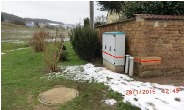
Der Schaltschrank einer Schmutzwasser-pumpstation stand nach Auskunft des Anliegers bis zu den Rohrkappen unter Wasser. Das Pumpwerk ist bei dem Hochwasser glücklicherweise nicht ausgefallen.
