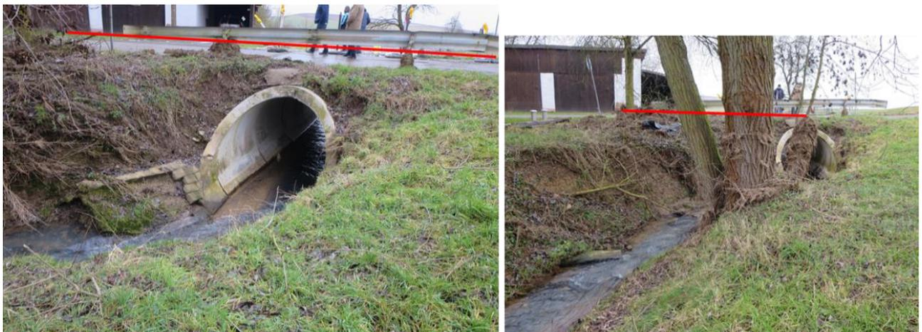
Die Folge sind Auskolkungen des Ufer- und Sohlverbau und der Ufer und damit verbunden Stabilitätsverlust des Durchlasses und der Straße. Im vorliegenden Fall wird empfohlen, die Ufer im Ober- und Unterwasser des Durchlassrohres durch massive Steinschüttung zu stabilisieren. Dabei sollte aus Stabilitätsgründen auf den Einsatz von Beton verzichtet werden. Außerdem wird
