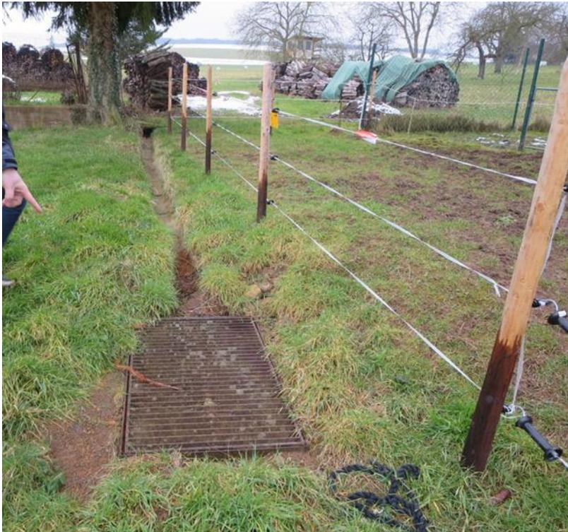
Der Hauptsammler des Drainagesystems endet in einer offenen Rinne aus Betonhalbschalen bzw. in einem größeren Schacht. Unterhalb des Schachtes folgt eine Verrohrung, die in das frühere Löschwasserreservoir mündet und in die Regenwasserkanalisation entwässert.
