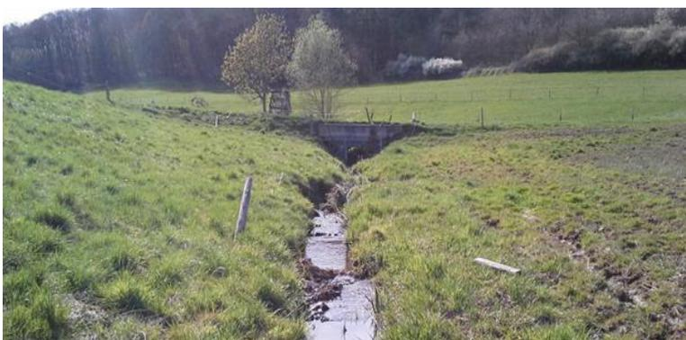
An dem zerstörten Durchlass unterhalb Bisterschied besteht aus wasserwirtschaftlicher Sicht kein Handlungsbedarf. Der eingebrochene Durchlass kann zwar nicht befahren werden, er hat jedoch eine positive und drosselnde Wirkung für Hochwasserabfluss.
