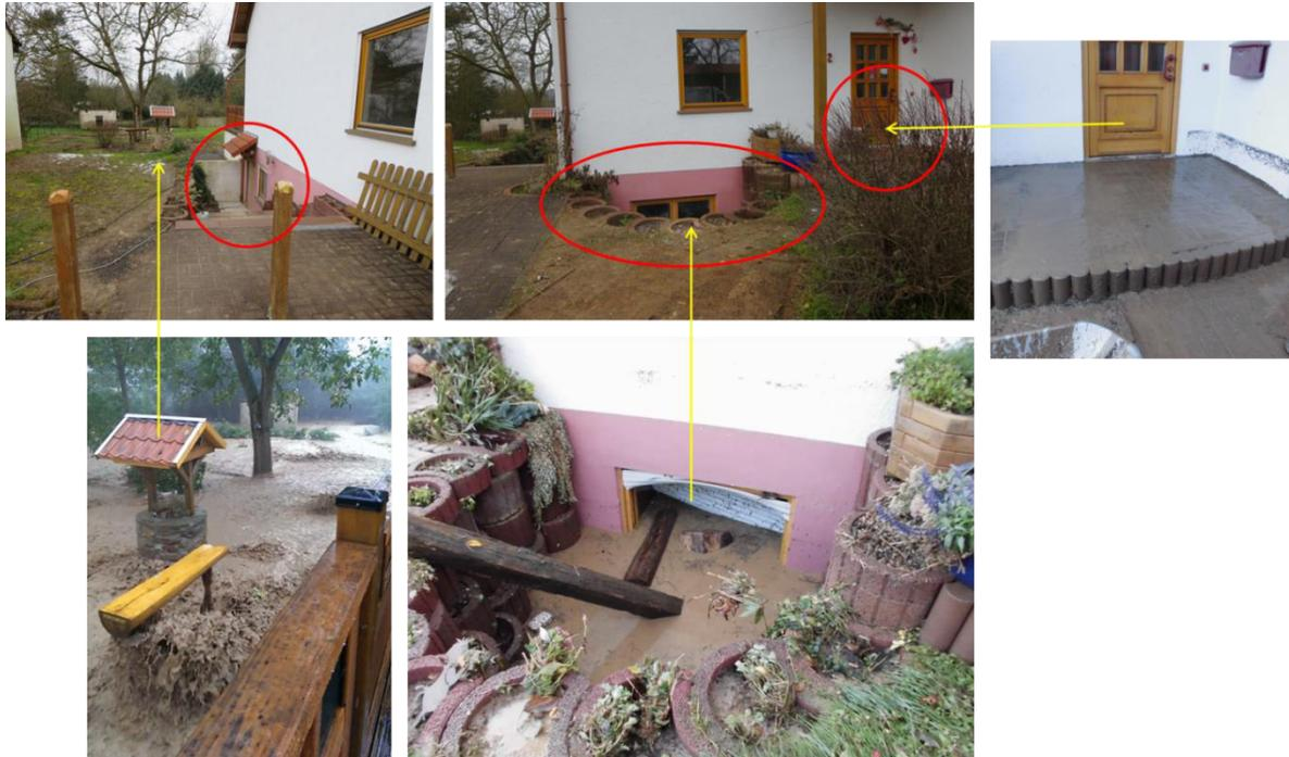
Der Keller und die Wohnräume im Untergeschoss liegen unter Geländeniveau und unter der Rückstauenebene der Kanalisation. Im Nachgang zu dem Schadensereignis im September 2014 wurden umfangreiche Objektschutzmaßnahmen an dem Gebäude durchgeführt (s. Abschnitt 10.1 und 10.2), das Anwesen bleibt jedoch, aufgrund seiner Lage, hochwassergefährdet.
