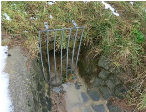
Das bestehende Einlaufgitter ist sehr ungeeignet, den Zutritt von Grobstoffen und Geschwemmsel in den Kanal zu verhindern, da es im Falle einer Verlegung nicht umströmt werden kann. Empfohlen wird ein größeres Einlaufgitter, das nicht direkt auf das Rohr aufsetzt ist. Vor dem Gitter sollte eine gepflasterte Mulde als Sandfang ausgebildet werden und das Gitter sollte räumlich schräg stehen. Aufgrund des Geländegefälles sollte talseitig in jedem Fall ein Kragen angeordnet werden.
